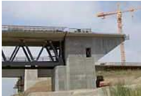
Estribos de un puente en construcción.
