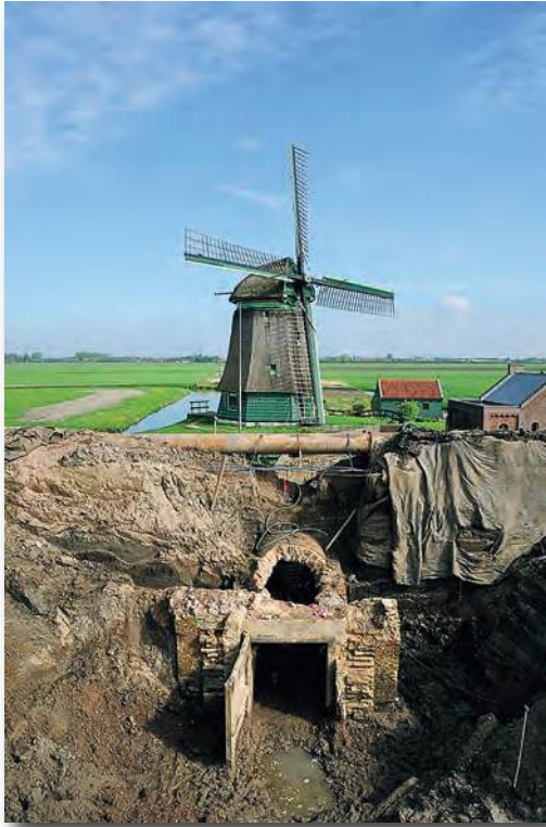
11.6 De koker van de sluis en de deur, met daar achter de molen en de polder.
