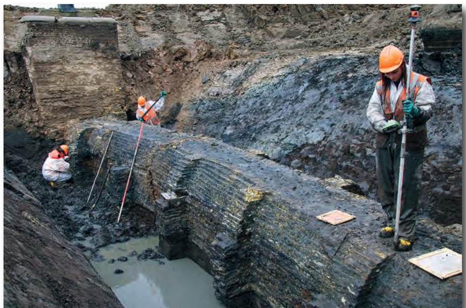
13.18 De steunberen aan de buitenzijde van het metselwerk.
