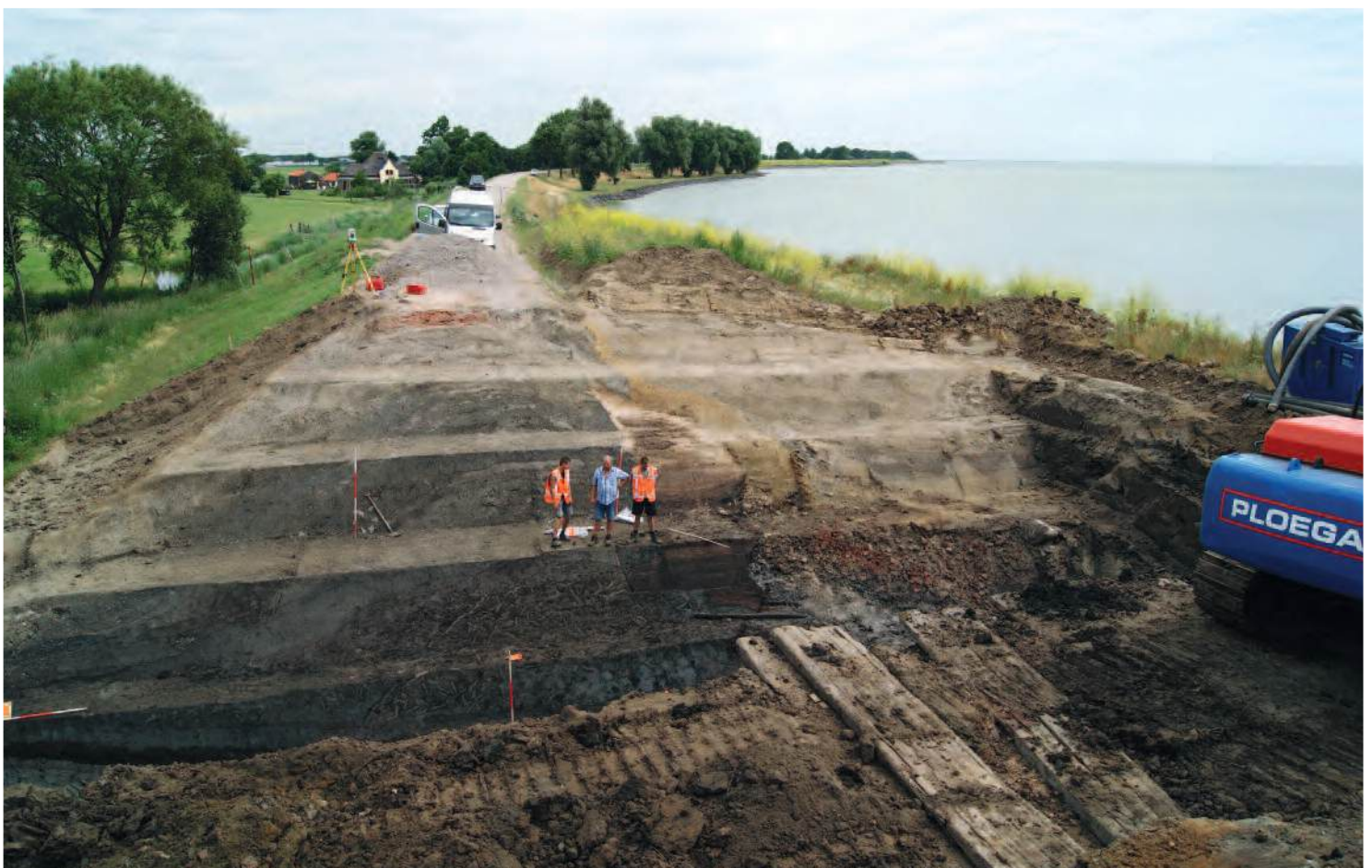
Een gezicht op de doorsnede dwars door de dijk bij Wijdenes op. Links polder de Drieban, rechts het Hoornse Hop.
