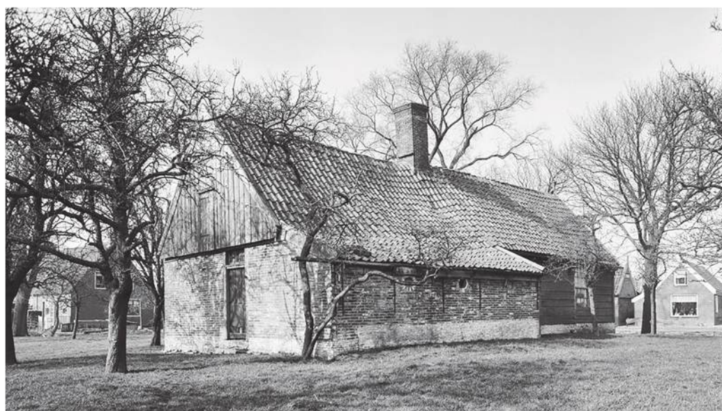
17.46 Oosterleek 39 rond het jaar 1978. Op deze foto is de wandbetimmering van gepotdekselde horizontale planken zichtbaar. Onder de wand is de bakstenen plint te zien.
