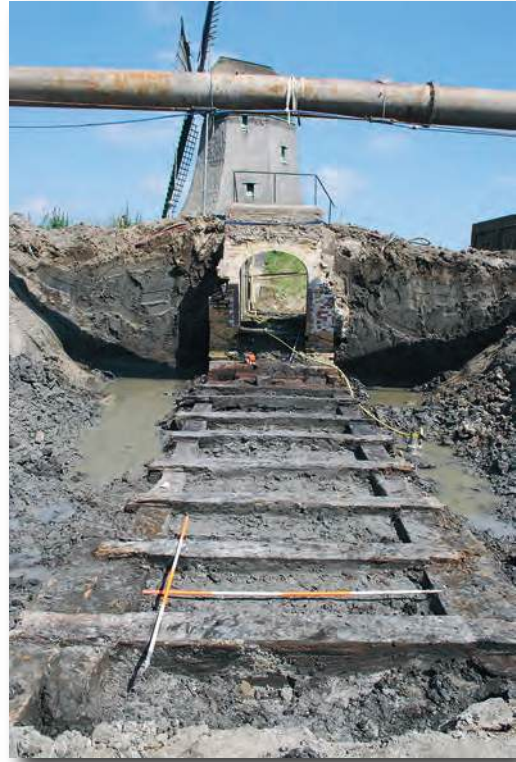
11.7 Onder de bakstenen koker lagen meerdere lagen hout als fundering. Dit raamwerk vormde de onderste laag. De dwarsliggers waren met zwaluwstaart en pen-gatverbinding vastgemaakt aan de langere liggers. Op de voorgrond zijn de extra balken ter hoogte van de sluisdeuren zichtbaar.
