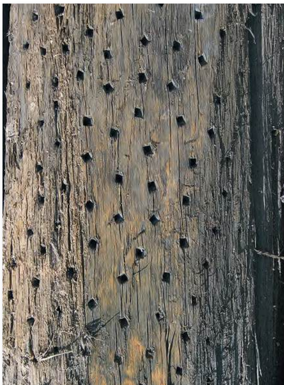
7.42 Vierkante spijkergaten van een wormspijkerpaal uit het havenhoofd van Medemblik.
