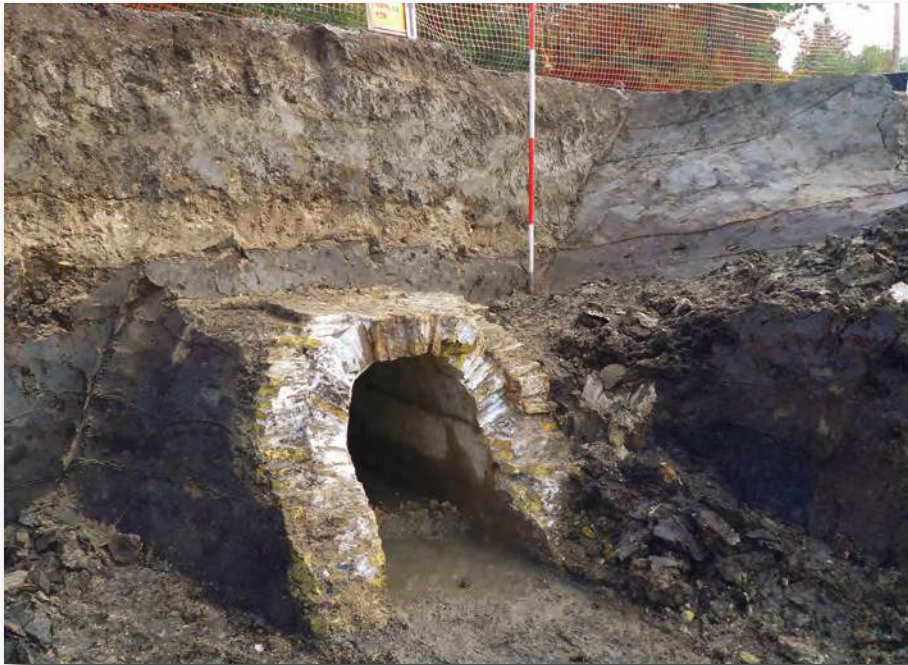
13.16 De koker van De Spuiter in doorsnede in de opgraving.
