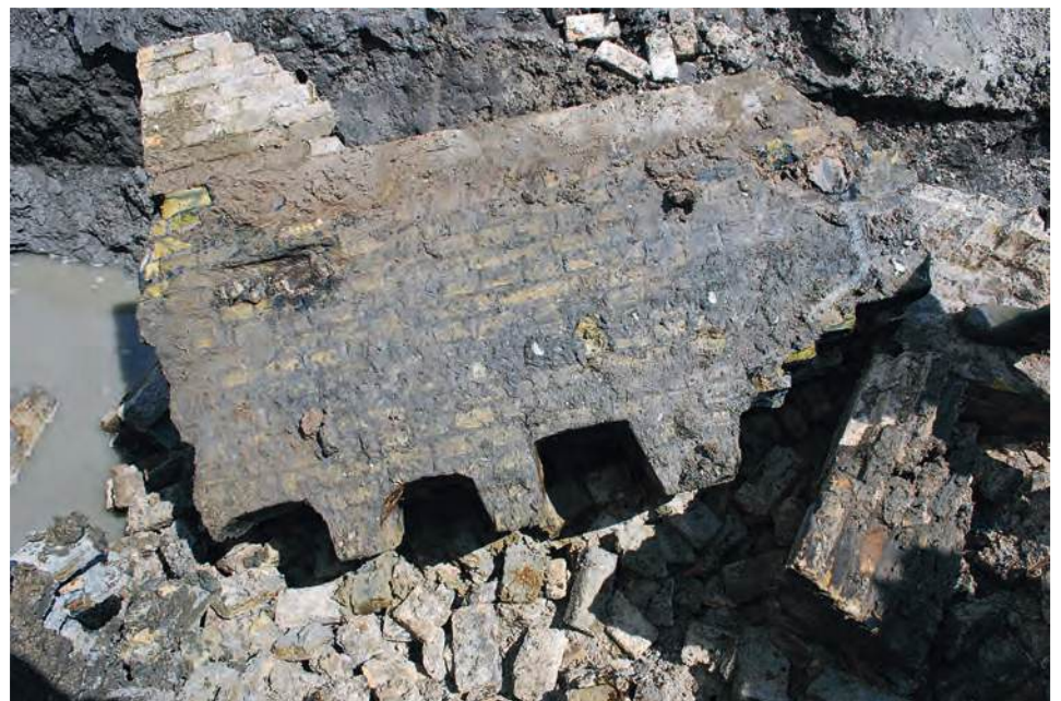
11.7 Onder de bakstenen koker lagen meerdere lagen hout als fundering. Dit raamwerk vormde de onderste laag. De dwarsliggers waren met zwaluwstaart en pen-gatverbinding vastgemaakt aan de langere liggers. Op de voorgrond zijn de extra balken ter hoogte van de sluisdeuren zichtbaar.
