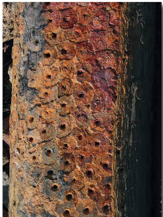
7.43 Het roestpantser van verkitte wormspijkers op een eiken paal uit de haven van Medemblik, opgegraven in 2014.
