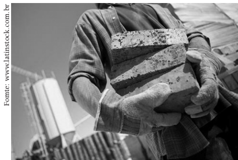
Figura 1: Pedreiro carregando tijolos
