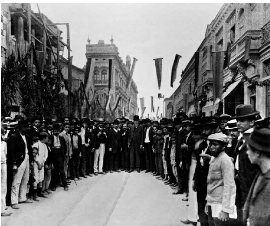
O prefeito Pereira Passos (no centro) entre populares em inauguração de obra da reforma
