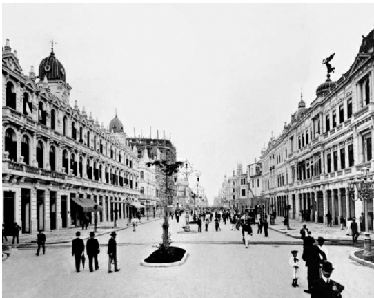
Aspectos da avenida Central durante a sua construção e recém-concluída
