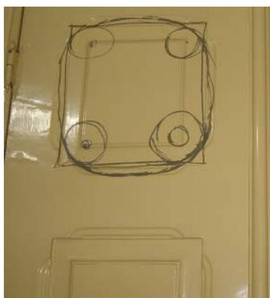
Fig. 2 - Esquisso representativo da forma como a máquina funcionava, deixando os cantos por trabalhar
