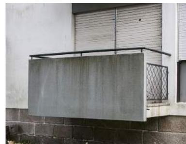
Fig. 59- Varanda e sua guarda em ferro
