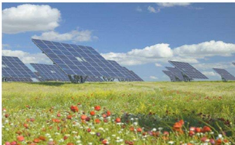
**Figura 20.** Instalación sobre suelo con sistemas de seguimiento
