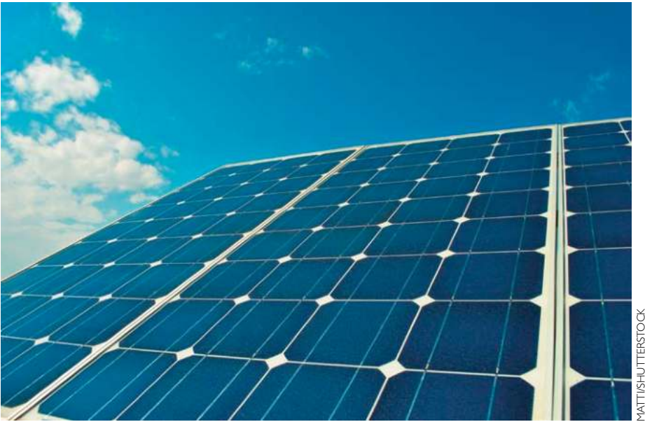
Figura 3.4 Painel com células solares, que liberam cargas elétricas sob incidência de luz.
