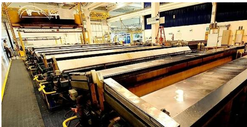
Figura 8- Tanque de tratamento químico.
