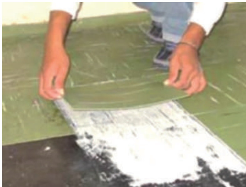
Aplicação de piso de borracha vinílica em placas. (Fonte: < http://www.adespec.com.br >. Acesso em: 26 set. 2007.)
