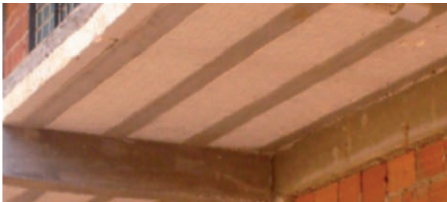
Laje com enchimento de isopor.
