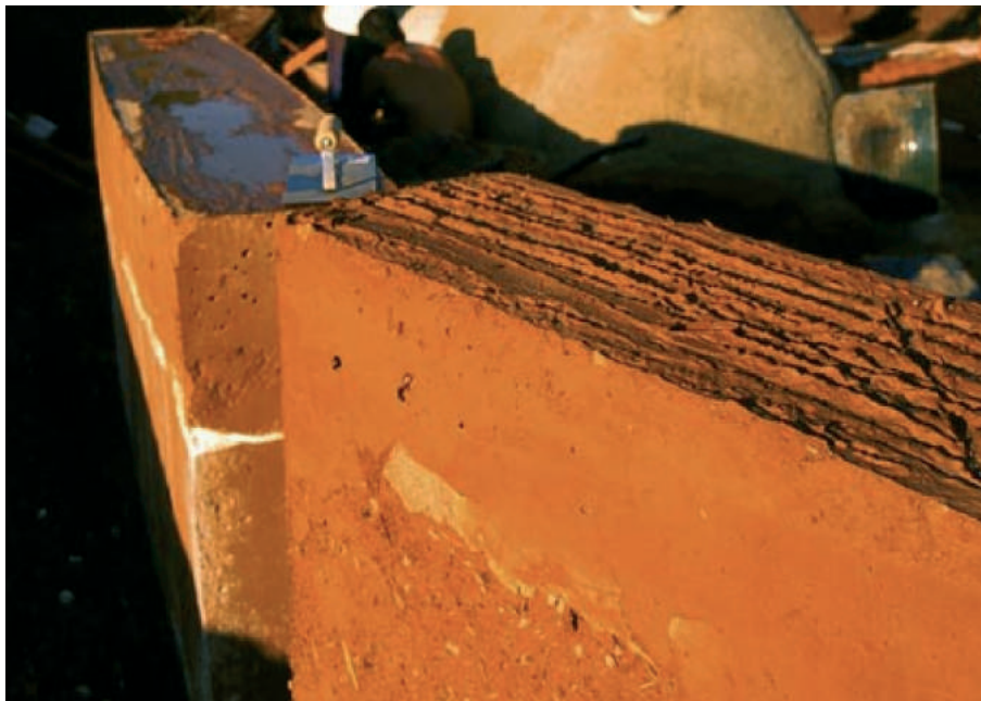
Parede confeccionada em taipa de pilão. (Fonte: < http://www.ecocentro.org >. Acesso em: 27 set. 2007.)
