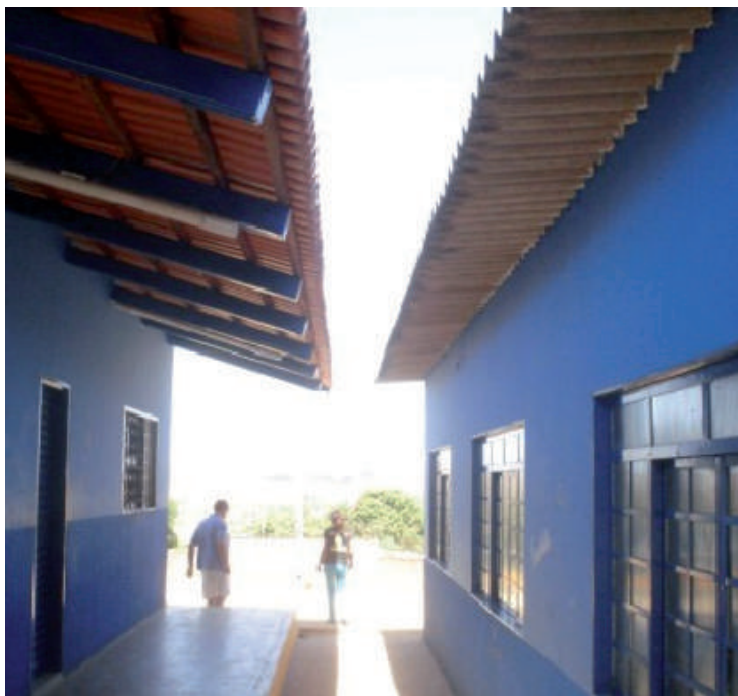
As telhas de cerâmica (à esquerda) são melhores isolantes térmicas do que as de fibrocimento (à direita).
