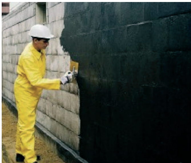
Impermeabilização de parede utilizando solução líquida de asfalto. (Fonte: < http://www.maxit.pt/2706 >. Acesso em: 26 set. 2007.)
