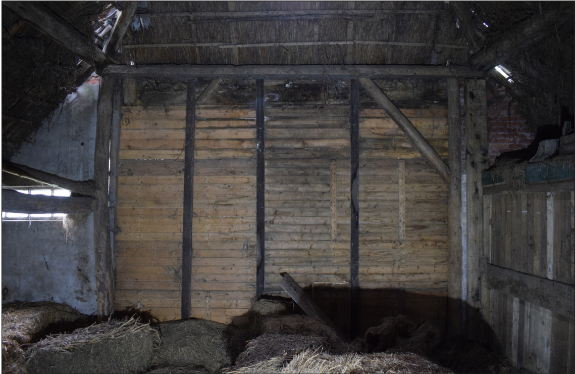
Afbeelding 30. De noordzijde van de houtconstructie met de houten buitengevel.
