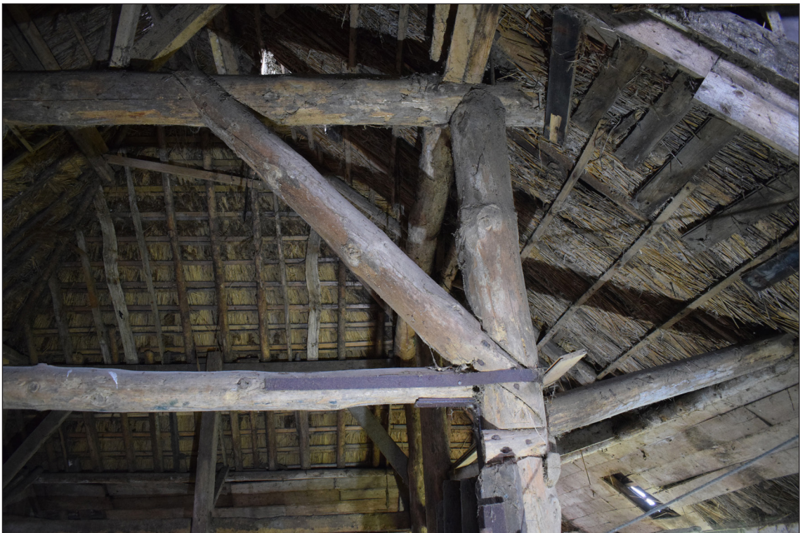
Afbeelding 31. Een van de originele zwingen.
