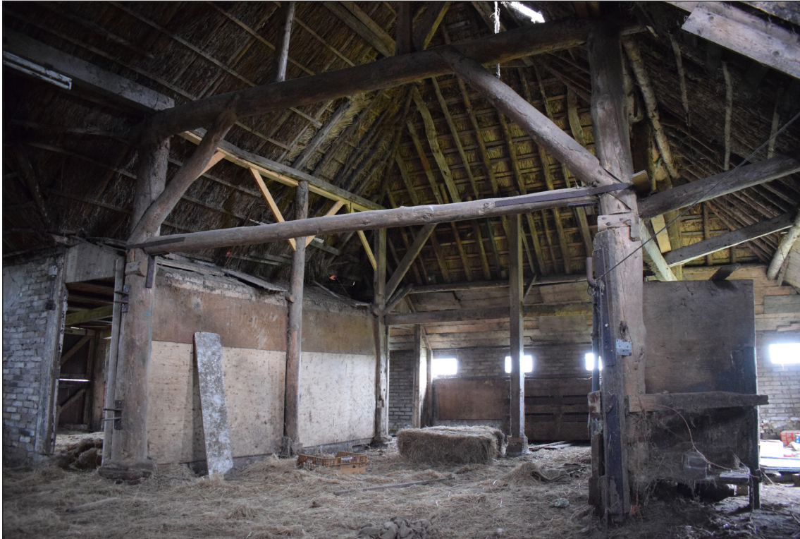
Afbeelding 32. Het zuidelijke hooivak, gezien vanuit de rijng. Halverwege de stijlen was oorspronkelijk een jaagband aanwezig. Deze is op zeker moment afgezaagd. Later is iets hoger een nieuwe jaagband geplaatst.
