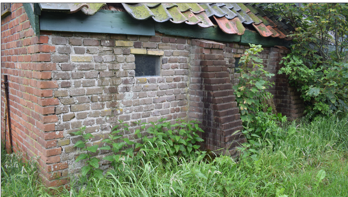
Afbeelding 8. De steunberen tegen de noordzijde van de westgevel.
