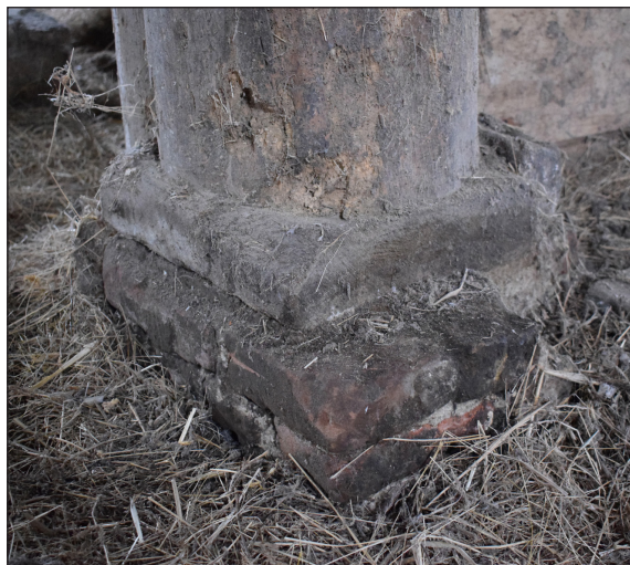
Afbeelding 33. Een poer met peulhout onder een van de stijlen.
