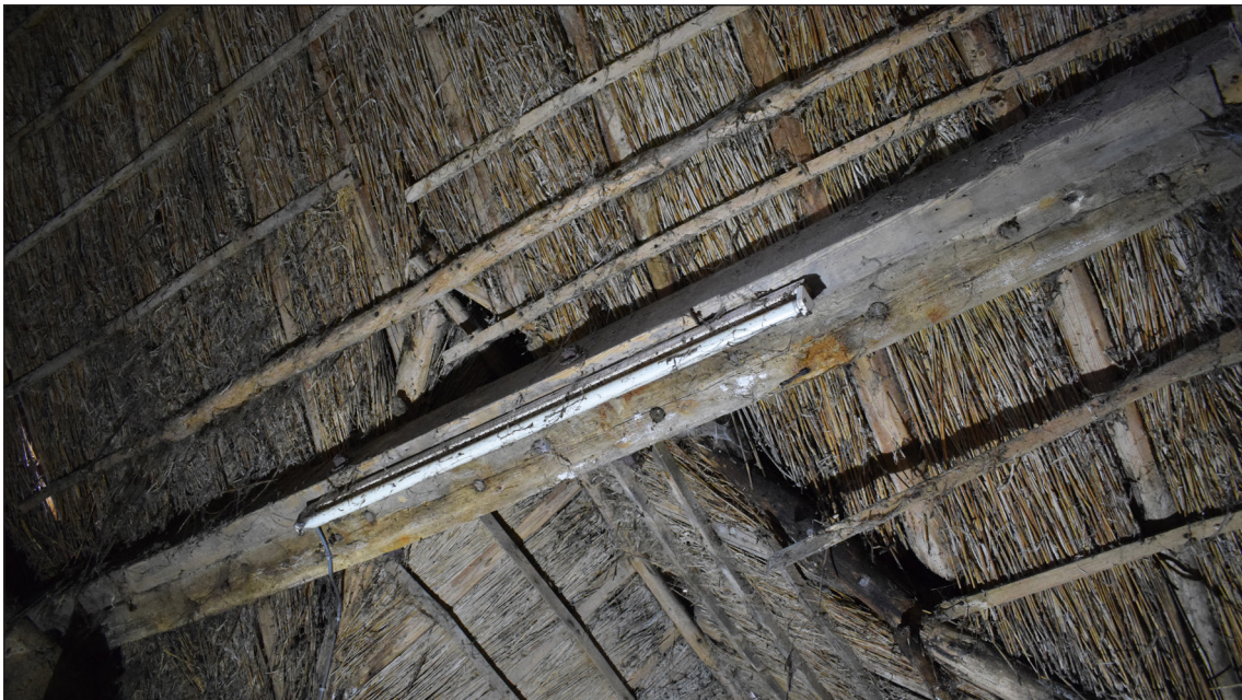
Afbeelding 29. Balk 22 met ronde pennen (rechts), met daar tegenaan nieuwe balk 27.
