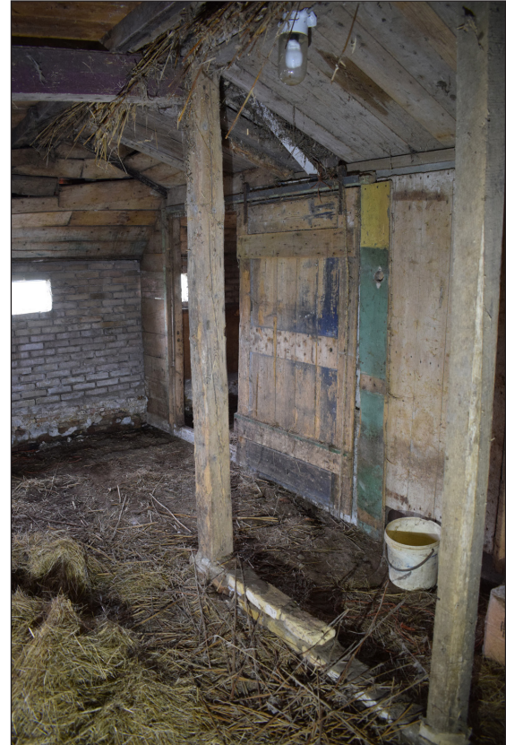
Afbeelding 20. Stijlen in de lage aanbouw met plat dak.
