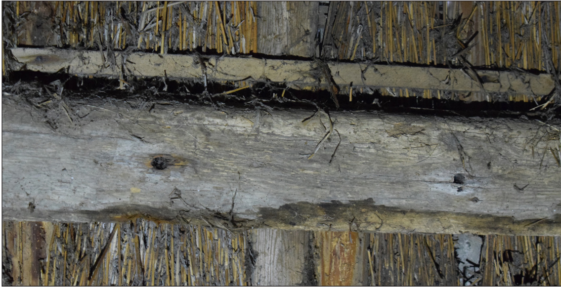
Afbeelding 28. Balk 24 met ronde gaten.
