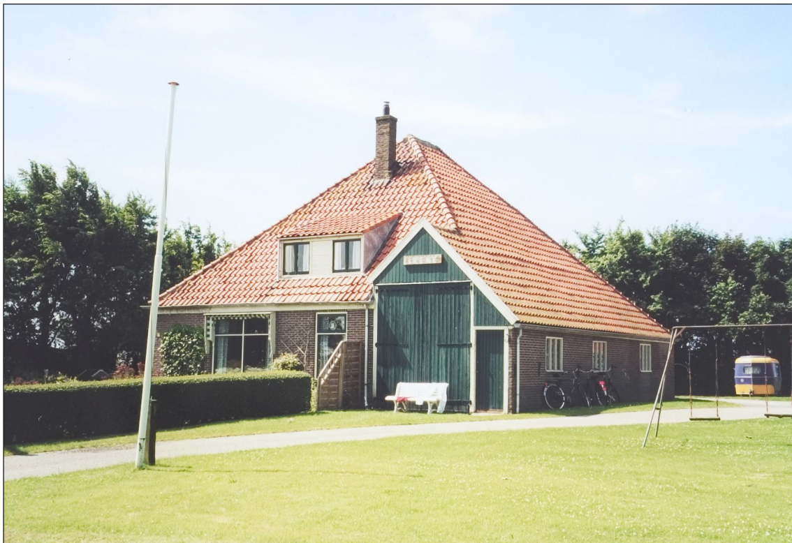
Afbeelding 43. Hemmerkooi 8, een andere stolpboerderij op Texel met wagendeuren met 'kapel'. Foto: Boerderijstichting Vrienden van de Stolp.
