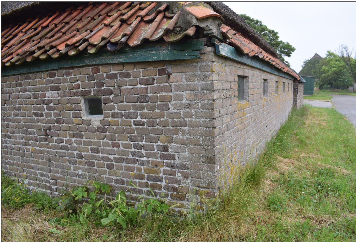
Afbeelding 11. De zuidwesthoek van de boerderij. De overgang tussen het moderne muurwerk van de zuidgevel en het oudere muurwerk van de westgevel is duidelijk zichtbaar.
