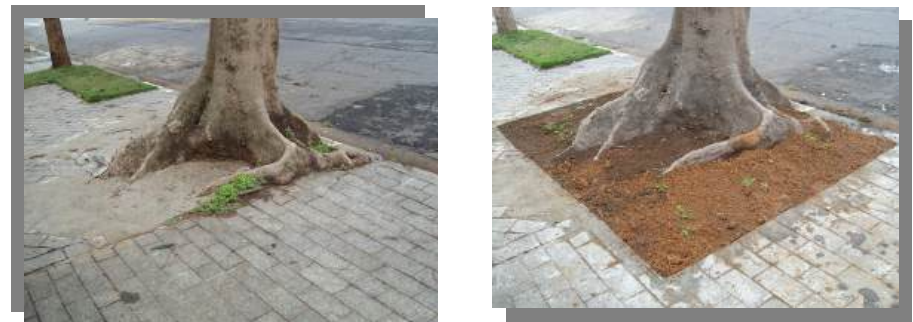
Figura 9: Técnica inadequada utilizando concretagem em torno de árvore versus modo adequado permitindo infiltração de água das chuvas
