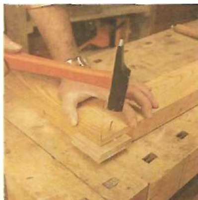
6. Colocação de pregos
