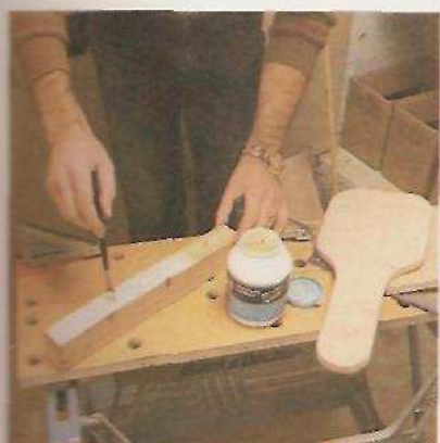
5. Colagem da barra de apoio
