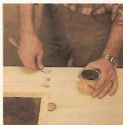
14. Tapagem dos buracos
