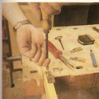
19. Colocação das dobradiças
