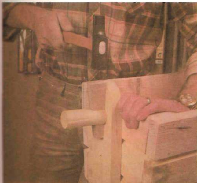
23. Colocação das cavilhas
