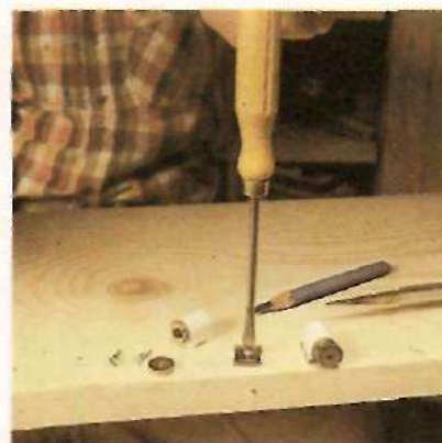
21. Colocação dos fechos
