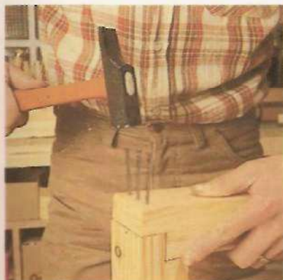
3. Colocação dos pregos de reforço
