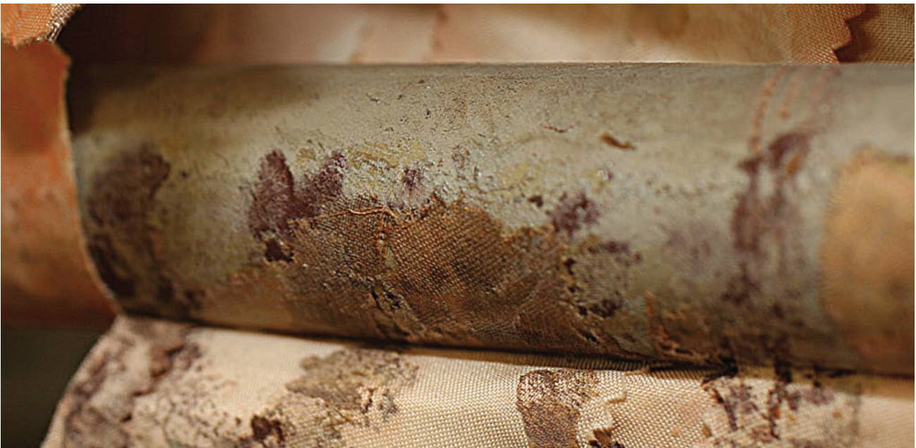
Figura 6-15. Ferrugem em componentes estruturais.
