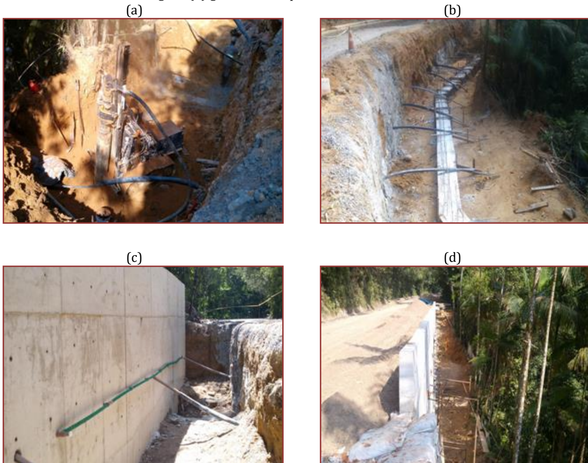
Figura 5. (a) execução estaca raiz, (b) vista geral dos tirantes incorporados a cortina, (c) detalhe sistema drenagem, (d) geometria da pista reconstituída com areia.
