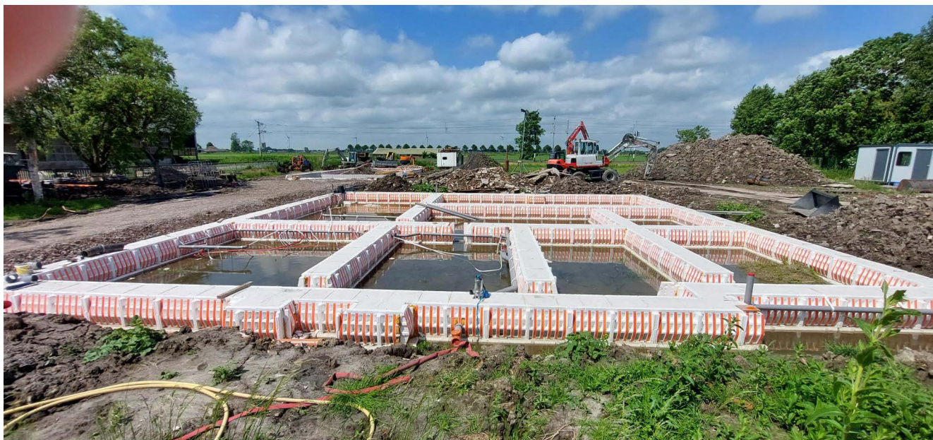
Afbeelding 27. De fundering van de nieuwe stolpboerdij Oosterblokker 176 is gelegd, mei 2024.
