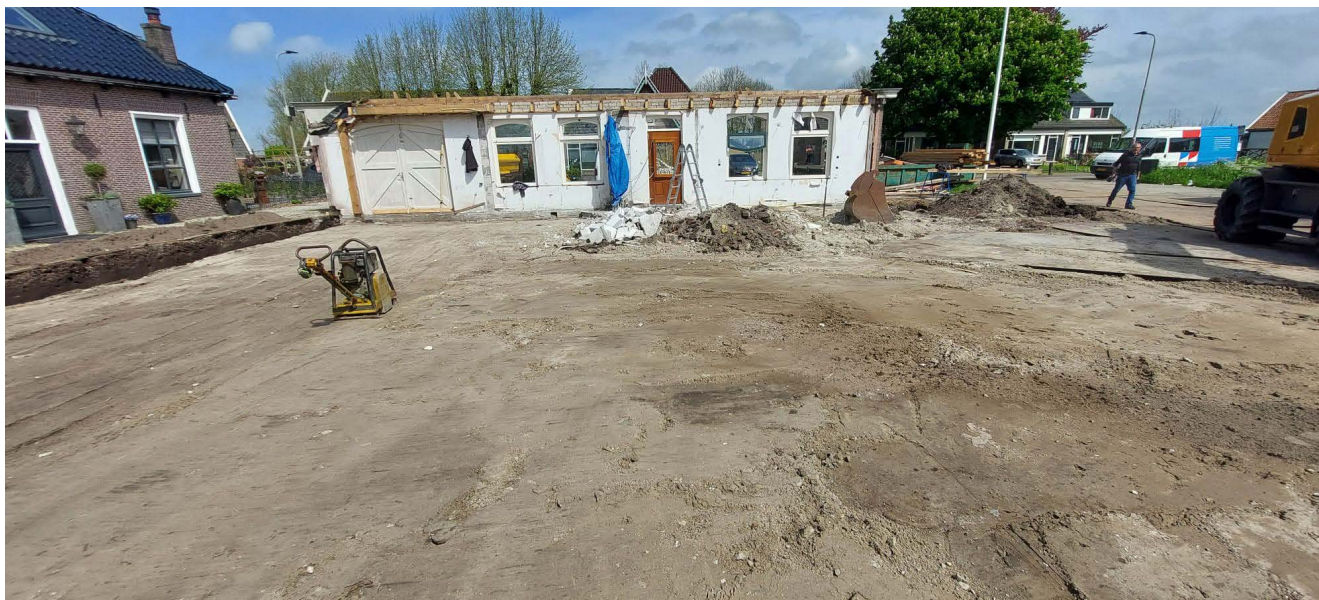
Afbeelding 31. De situatie op 30 april 2024 van de gesloopte stolpboerderij aan Wadway 29, waarvan alleen de voorgevel bleef staan.
