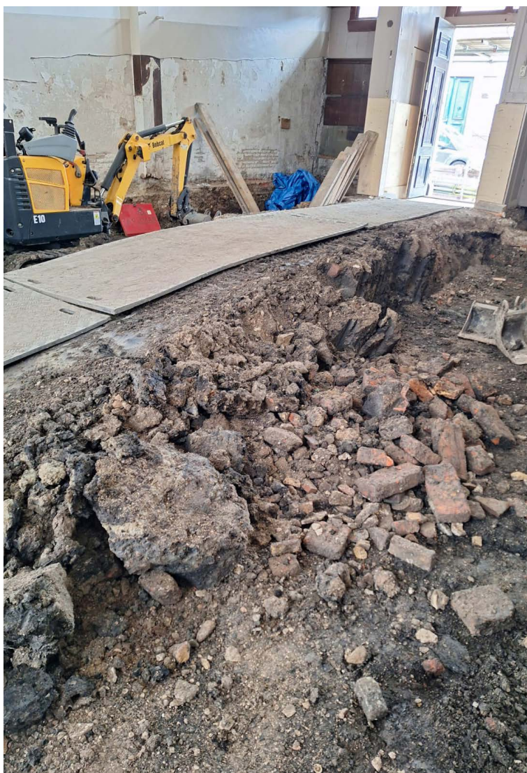
Afbeelding 28. De ontgraving aan de Breedstraat 40 ging dieper dan de toegestane 30 cm.
