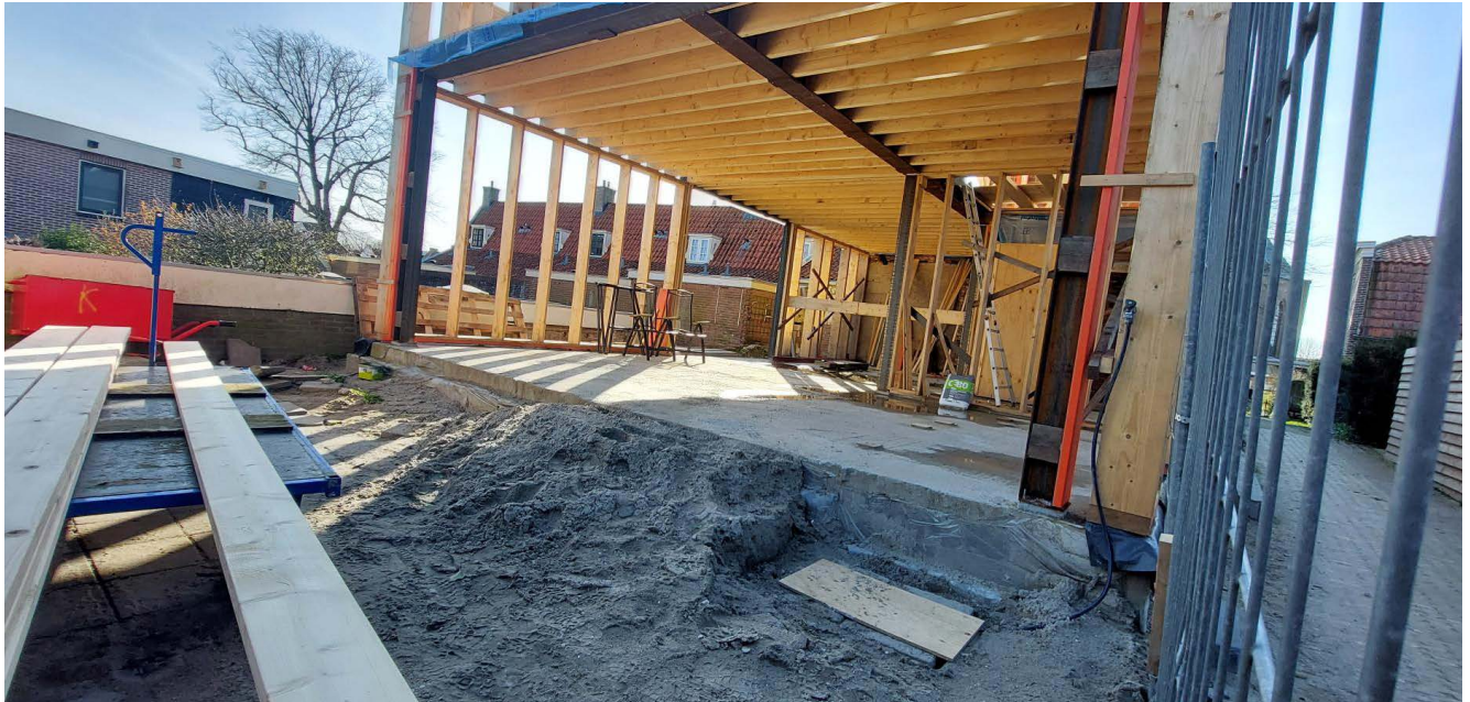
Afbeelding 26. Aan de Kerksteeg 5 is houtskeletbouw op een betonplaat gerealiseerd. Dat spaart een de archeologie in de bodem en daarmee de kosten voor een onderzoek.
