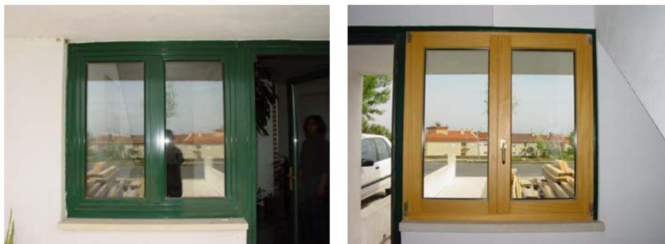
Fig. 65 - Face exterior em alumínio (à esquerda) e face interior em madeira (à direita)
