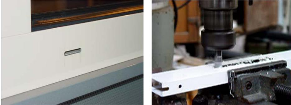
Fig. 58 - À esquerda, rasgo para drenagem e, à direita, perfuração com fresa
