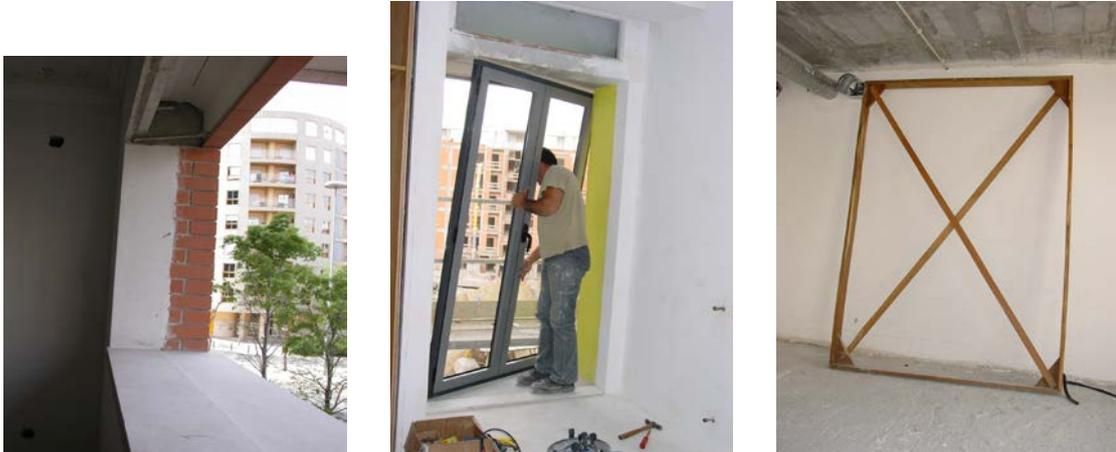
Fig. 88 - À esquerda, vão preparado para a montagem da caixilharia, ao centro, montagem da mesma e, à direita, molde da caixilharia
