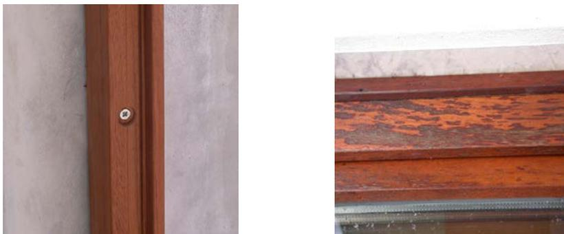
Fig. 37 - À esquerda, junta preenchida por silicone e, à direita, por espuma de poliuretano
