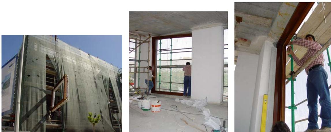
Fig. 91 - Colocação dos caixilhos em obra (à esquerda) e no vão (ao centro) e, à direita, aferição com nível
