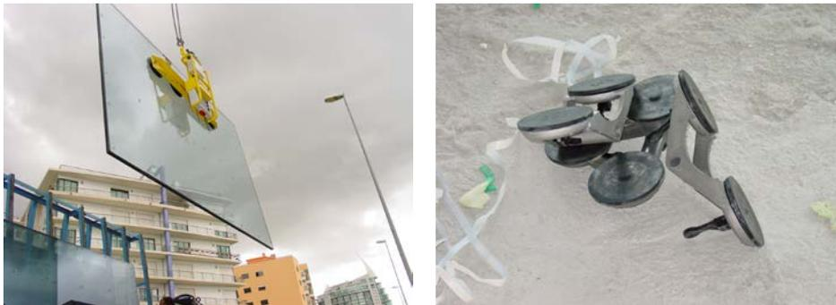
Fig. 99 - Colocação do vidro em obra (à esquerda) com auxílio de ventosas (à direita)
