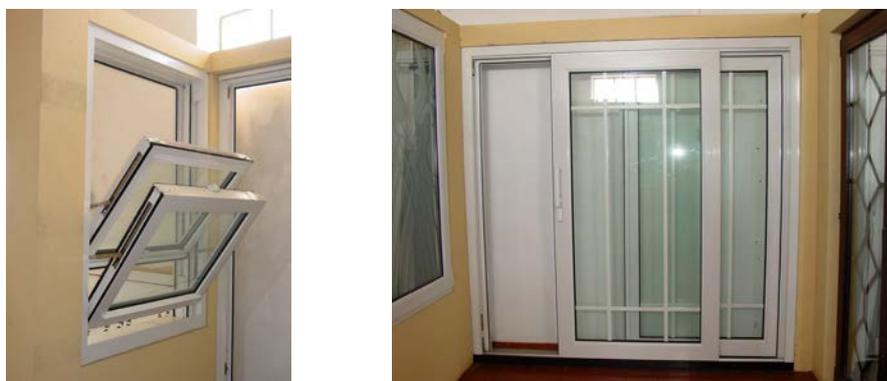
Fig. 20 - Caixilhos: à esquerda, de guilhotina basculante e, à direita, de correr basculante
