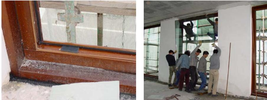
Fig. 100 - À esquerda, posicionamento dos calços inferiores e, à direita, colocação do vidro
