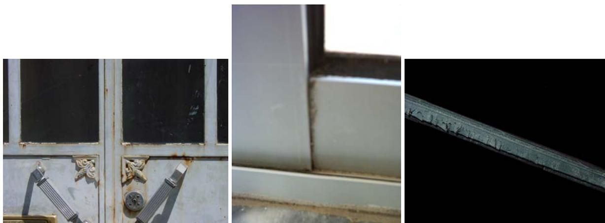
Fig. 113 - À esquerda, corrosão de caixilharia de aço por falta de manutenção, ao centro, aparecimento de fungos e bolores e, à direita, borracha ressequida
