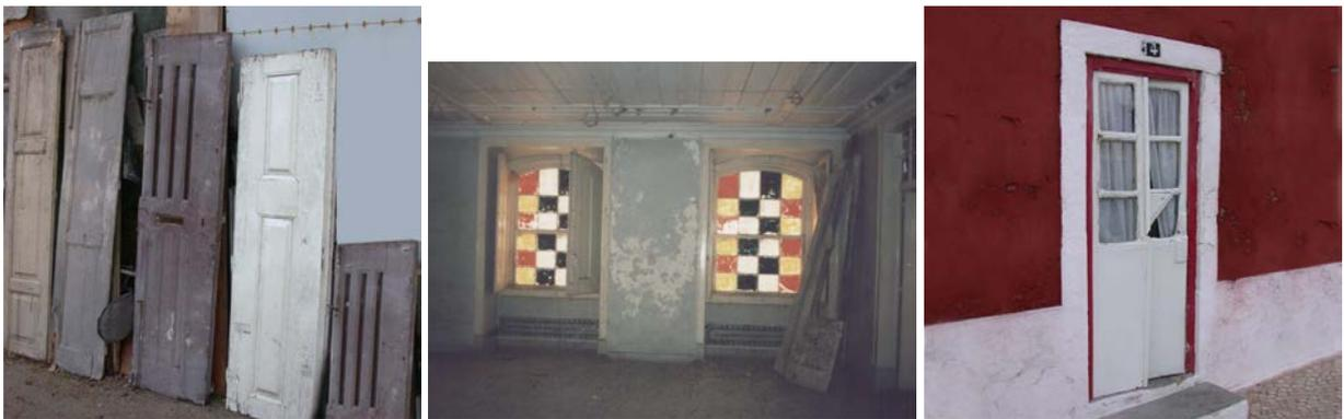
Fig. 1 - À esquerda, portadas exteriores, ao centro, portadas interiores e, à direita, porta exterior
