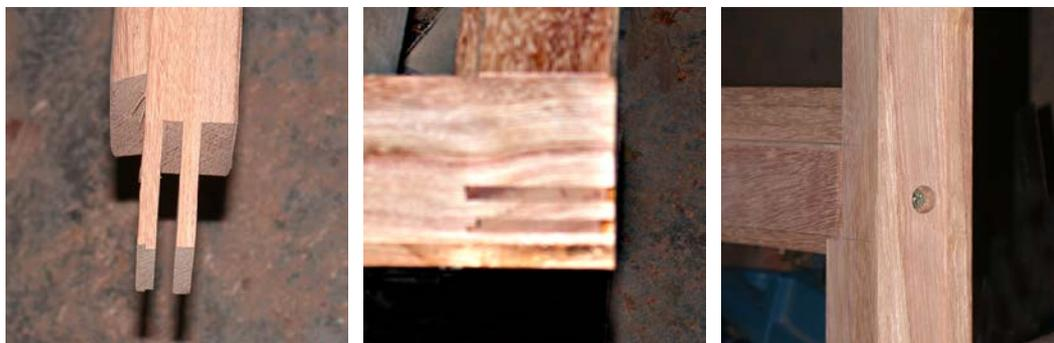
Fig. 35 - À esquerda, entalhe, ao centro, união colada e, à direita, união aparafusada
