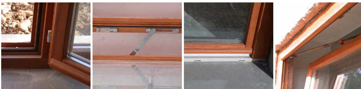
Fig. 28 - Da esquerda para a direita, caixilharia de abrir, basculante, corredora-elevadora e oscilo-batente
