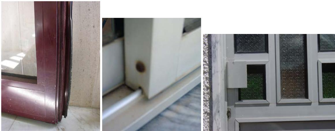
Fig. 114 - À esquerda, deslocamento do vedante, ao centro, parafuso oxidado e, à direita, porta encravada por dilatação do caixilho
