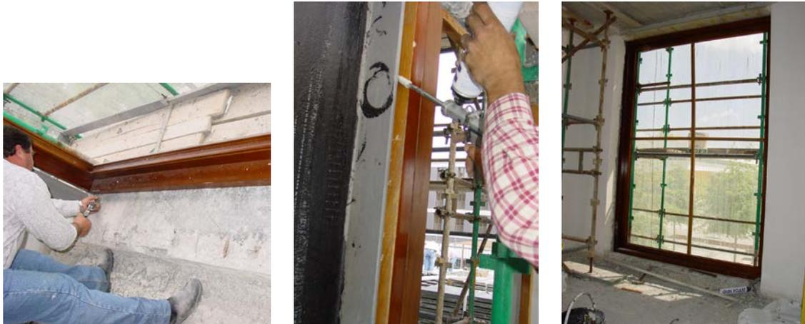
Fig. 94 - Aplicação de poliuretano (à esquerda e ao centro) e travessas em forma de cruz (à direita)
