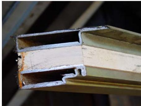
Fig. 85 - Perfil com protecção corta-fogo
