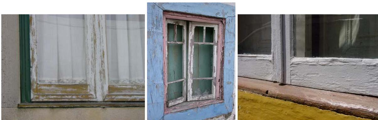
Fig. 109 - Degradação de caixilharias de madeira: à esquerda, pintura desgastada, ao centro, envelhecimento acentuado e, à direita, tinta empolada
