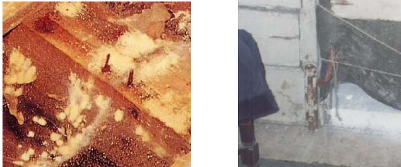
Fig. 111 - Degradação de caixilharias de madeira: à esquerda, danos provocados pelo caruncho das mobílias e, à direita, oxidação de ferragens
