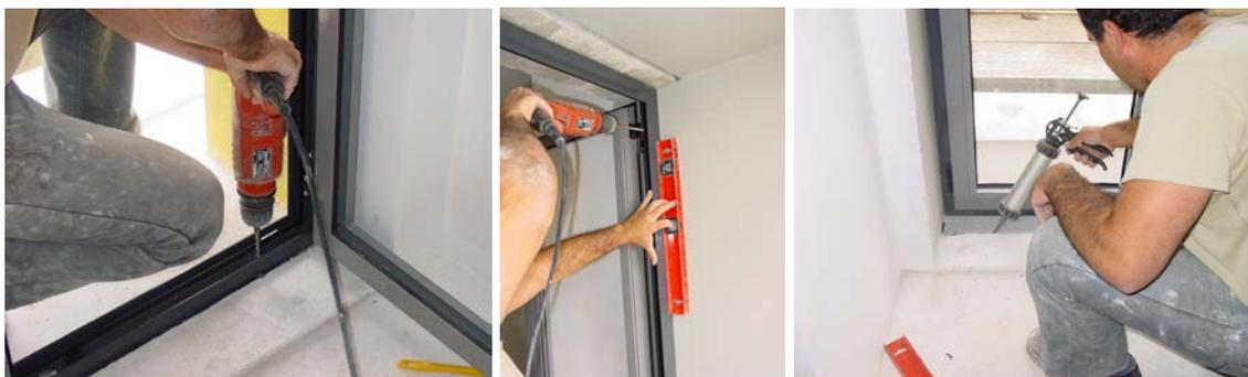
Fig. 95 - À esquerda, fixação com parafusos, ao centro, fixação e aferição com nível e, à direita, aplicação de cordão de silicone
