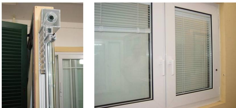
Fig. 21 - Caixilharias com caixa de estore (à esquerda), persiana interior (à direita)
