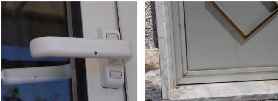
Fig. 112 - Degradação de caixilharias de alumínio: à esquerda, degradação da lacagem e, à direita, corrosão por proximidade do mar
