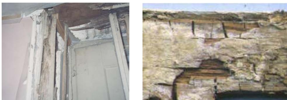
Fig. 110 - Degradação de caixilharias de madeira: à esquerda, desintegração da superfície da madeira e, à direita, podridão seca
