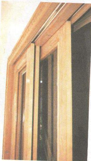
En algunos casos, el riel que carga el peso de la puerta es el superior, colocado como dintel del marco. Las carretillas van fijas al bastidor y cuelgan del riel, que debe estar apropiadamente lubricado.
