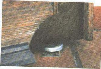
Muy parecidas a las tubulares son las bisagras de pivote, ya que también tienen una pieza hembra y una macho, pero no se colocan entre la jamba y el canto del bastidor, sino que, por arriba, unen el dintel del marco con el cabezal de la puerta o cabio alto y, por abajo, el cabio bajo o zócalo con el umbral.
