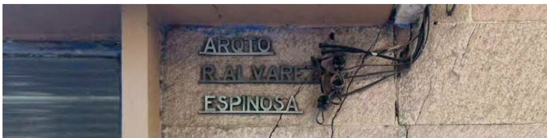
Figura 21. Epígrafe arquitetônica com letras de metal unidas por barra encontradas na Cidade do México (México).
