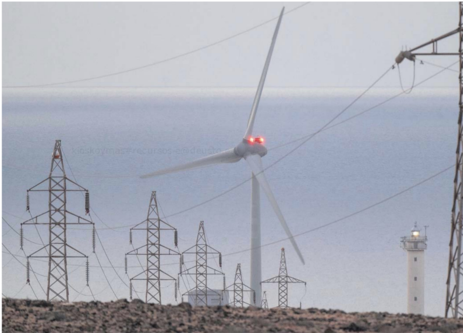
Tendido eléctrico a las afueras de Puerto del Rosario, en Fuerteventura. CARLOS DE SAÁ (EFE)
