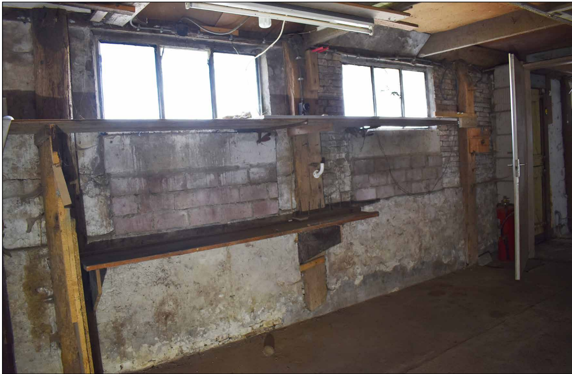
Afbeelding 33. De binnenzijde van de noordgevel, met houten muurstijlen.
