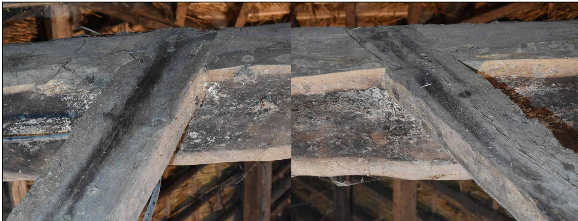
Afbeelding 52. Bevestiging van twee zwingen op de noordelijke dekbalk door middel van een lipverbinding met hak.
