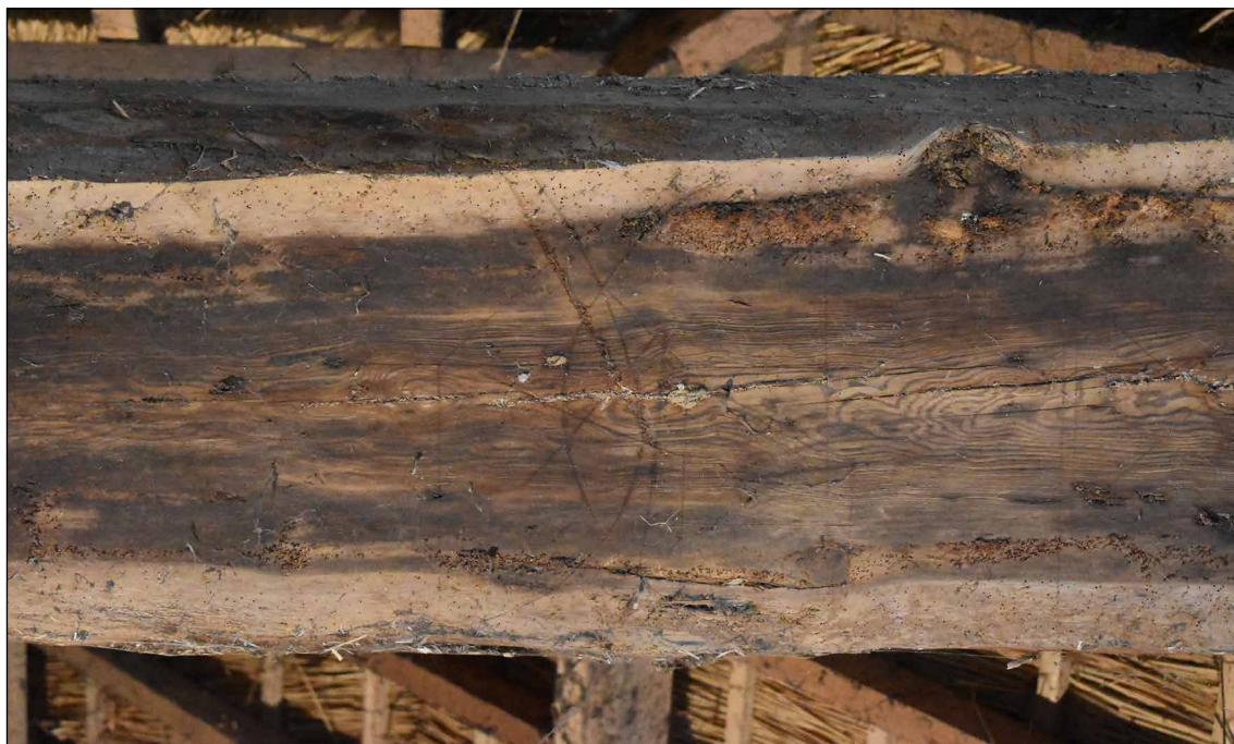
Afbeelding 47. Handelsmerk op de onderzijde van de noordelijke dekbalk.
