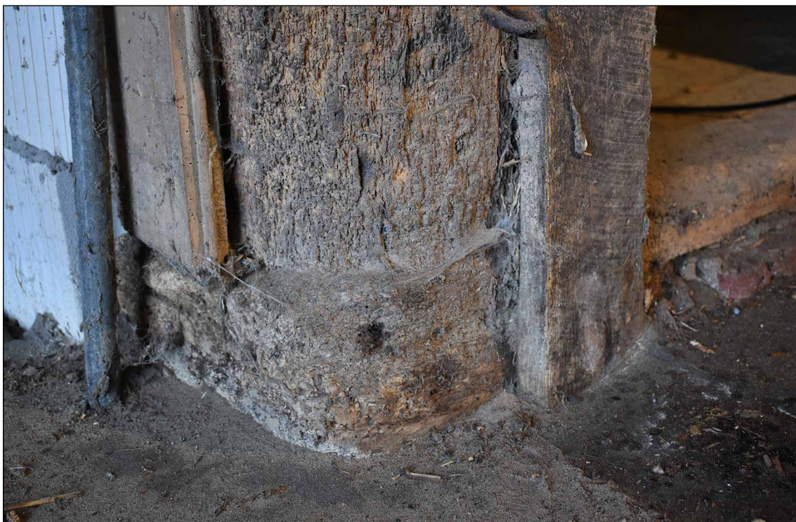
Afbeelding 48. Onderkant van de noordwestelijke stijl, met daaronder het peulhout van eikenhout.
