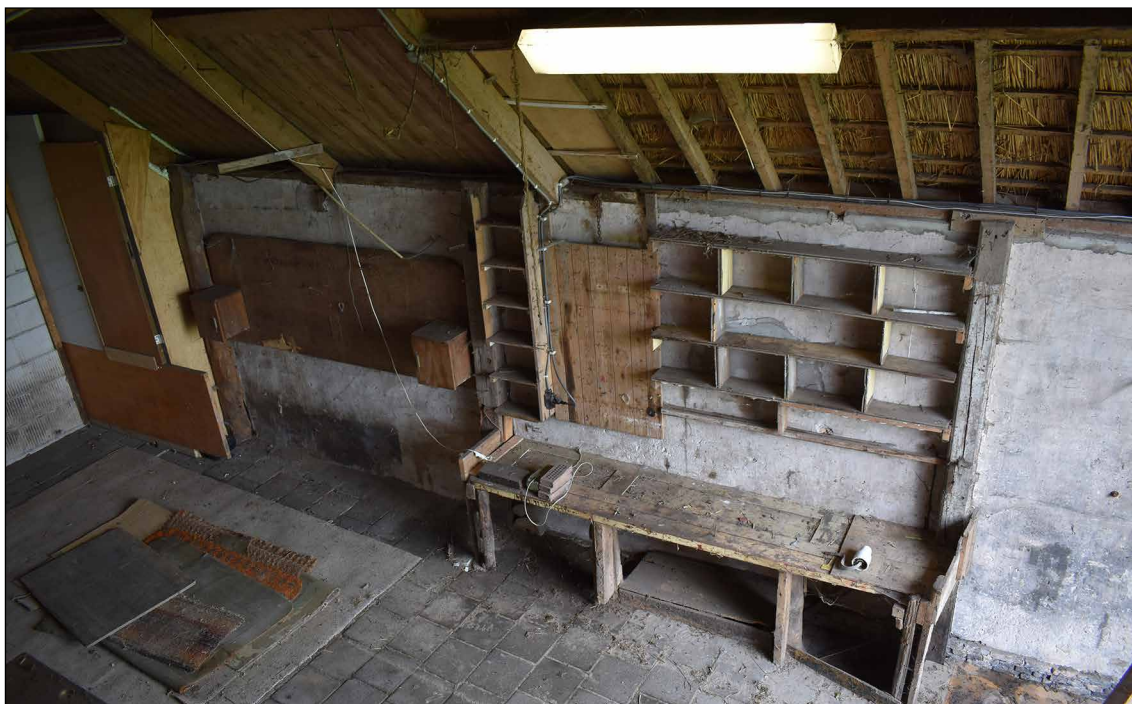
Afbeelding 35. De binnenzijde van de westgevel met muurstijlen, gezien vanaf de zolder.
