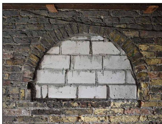
Afbeelding 27. Dichtgezet half rond stalraam in de oostgevel.
