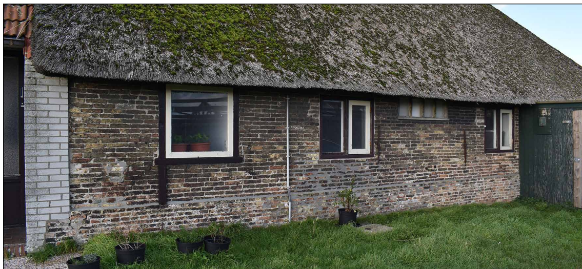
Afbeelding 24. Oud metselwerk aan de oostzijde van de boerderij.
