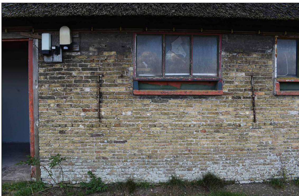
Afbeelding 30. Detail van de noordgevel, ten westen van de deur.
