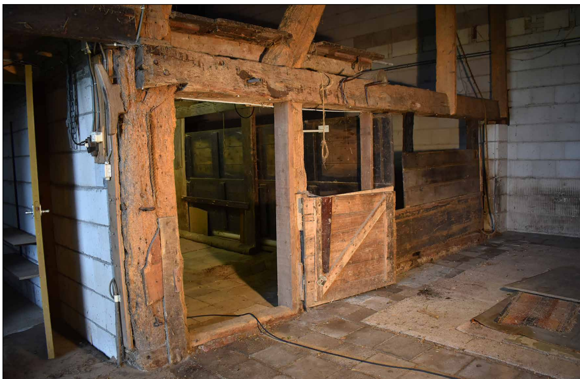
Afbeelding 50. De eiken draagbalk aan de westzijde van het vierkant.
