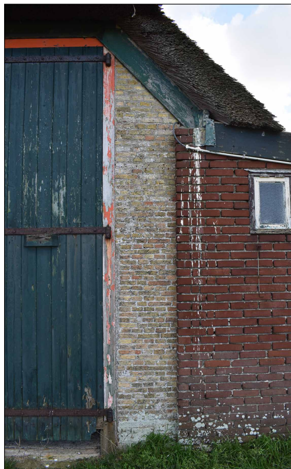
Afbeelding 32. Detail van het muurwerk ten westen van de wagendeuren.
