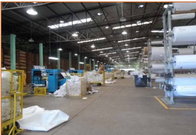
Figura 3 – Setor de Rebobinadeira
