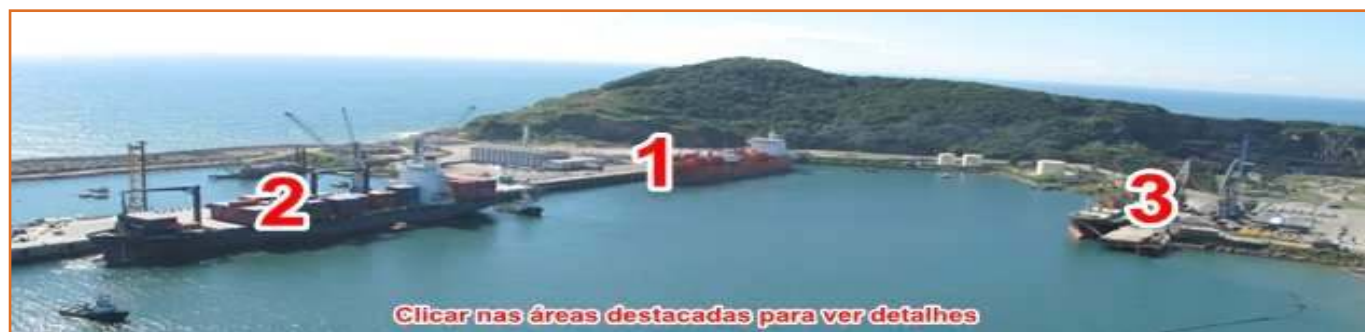
Figura 2- Berço de atracação Porto de Imbituba.
