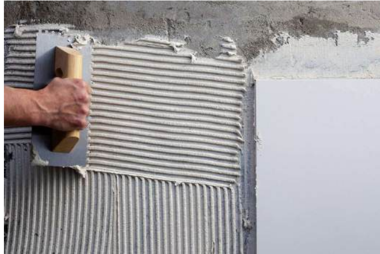
Figura 87 – Aplicação de argamassa colante com desempenadeira dentada.
