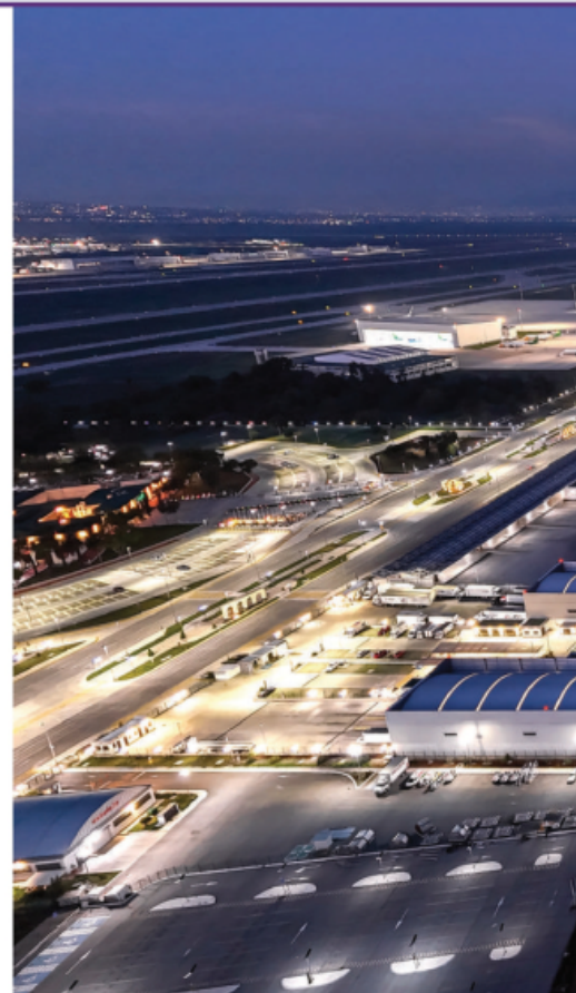
PLATAFORMA de carga de la terminal en una vista aérea, en imagen de archivo.
