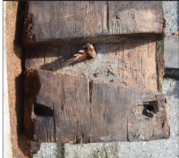
Afbeelding 51. Loef in de onderkant van de noordelijke dekbalk (boven) en onderkant van de overstekbalk.
