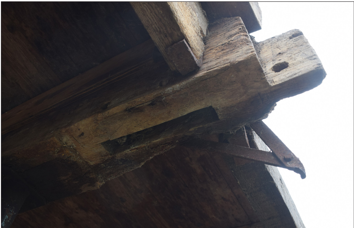
Afbeelding 35. Een van de zolderbalken van de koeienstal, met pengat voor een korbeel en een pen voor een stijl.
