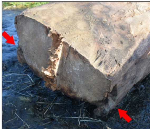
Afbeelding 75. Twee deels weggezaagde vlotgaten in de bovenkant van de noordoostelijke stijl.
