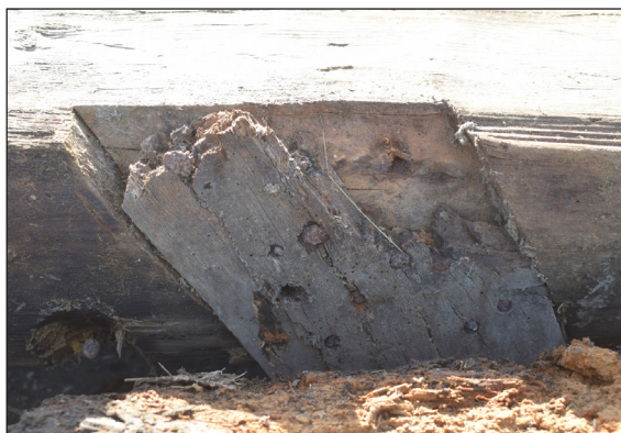
Afbeelding 59. Lipverbinding zonder hak op de oostelijke dekbalk.
