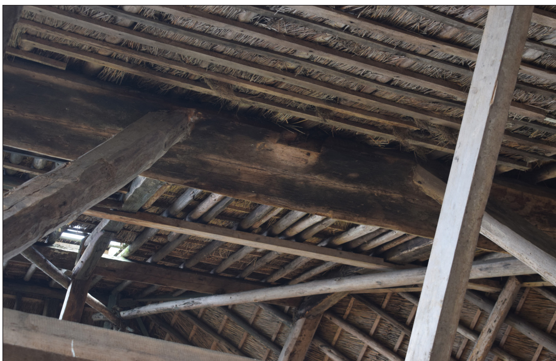
Afbeelding 57. De zuidelijke bovenbalk van onder gezien. Tussen de zwingen bevindt zich een lege inkeping van een zwing.
