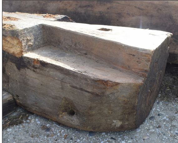
Afbeelding 73. Een vlotgat in de westelijke dekbalk.
