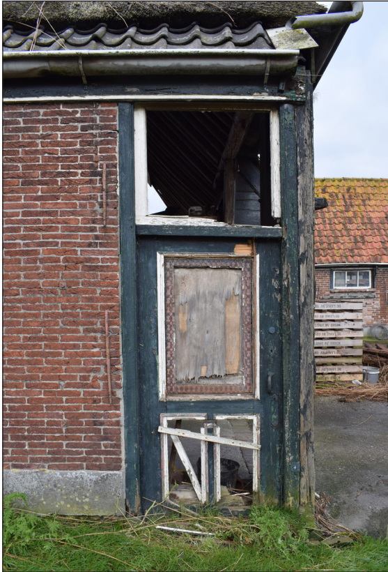
Afbeelding 17. Deur in de zuidgevel.
