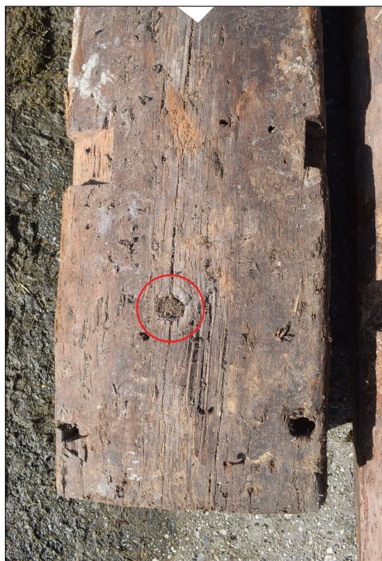
Afbeelding 48. Pen in het ronde gat (binnen cirkel) aan de andere zijde van de zuidoostelijke stijl.
