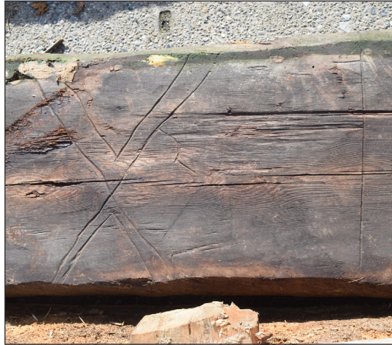
Afbeelding 65. Merk op de overstekbalk.
