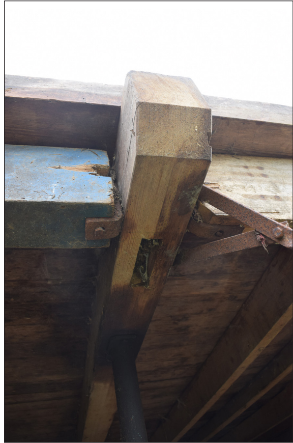
Afbeelding 34. Een van de zolderbalken van de koeienstal, met pengat voor een stijl.
