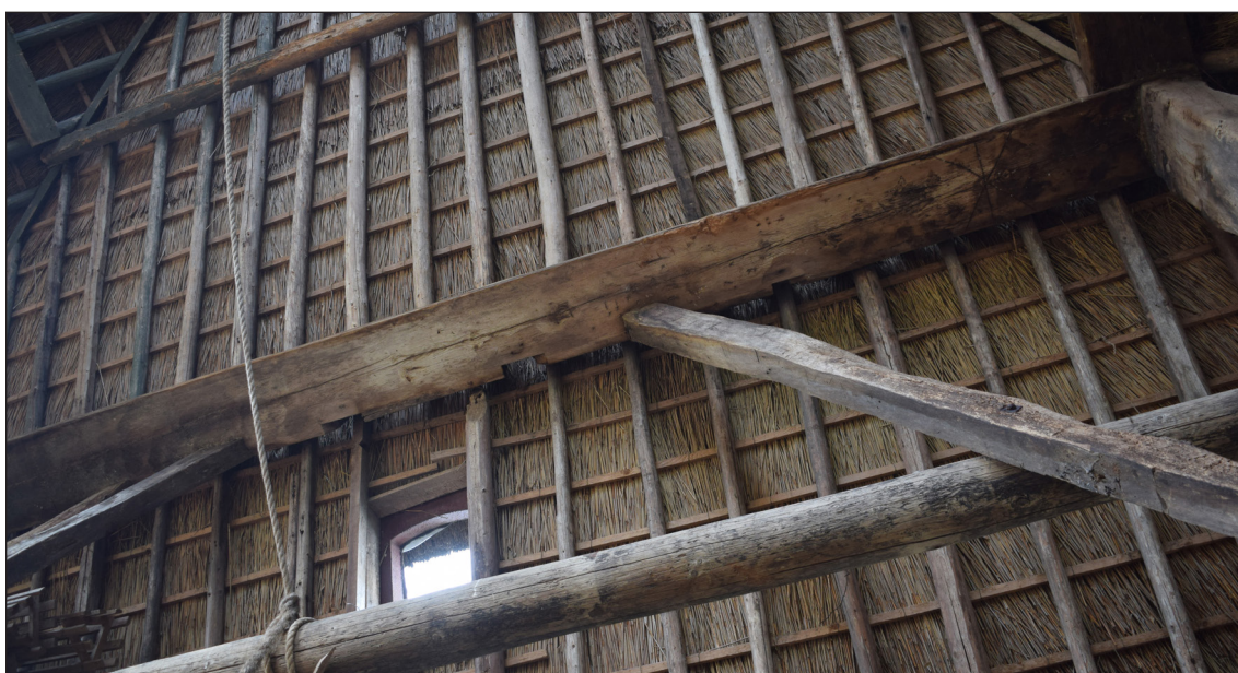
Afbeelding 58. De oostelijke dekbalk van onder gezien. Op de achterkant van de balk zijn diverse lege inkepingen van verdwenen zwingen aanwezig.
