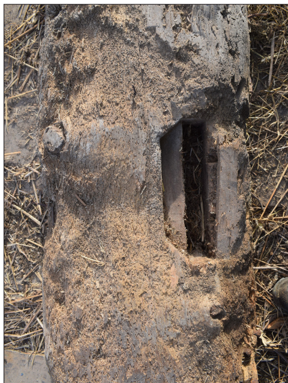
Afbeelding 54. Pengat van een draagbalk in de noordwestelijke stijl.
