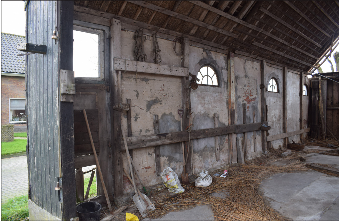
Afbeelding 28. De binnenzijde van de zuidgevel, gezien vanuit de dars.
