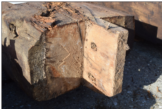
Afbeelding 45. Pen aan de bovenzijde van de zuidwestelijke stijl.
