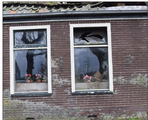
Afbeelding 11. Detail van de voorgevel met gietijzeren muurankers.
