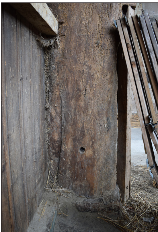
Afbeelding 47. Rond gat in de onderzijde van de zuidoostelijke stijl.
