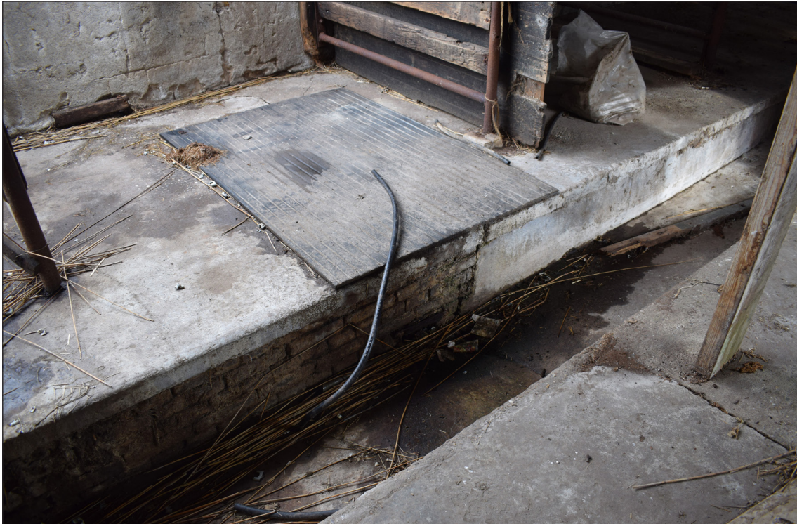
Afbeelding 32. De mestgoot op de overgang van de stolpboerderij naar de schuur. Binnen de stolp zijn de zijkanten van de mestgoot bakstenen muren, binnen de schuur is dit van beton.
