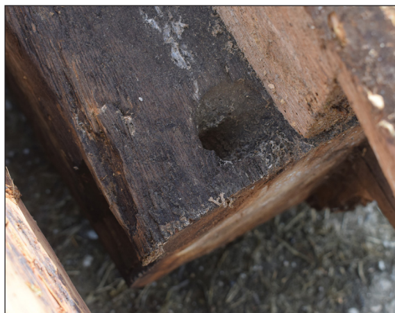
Afbeelding 76. Een vlotgat in de bovenkant van de zuidoostelijke stijl.
