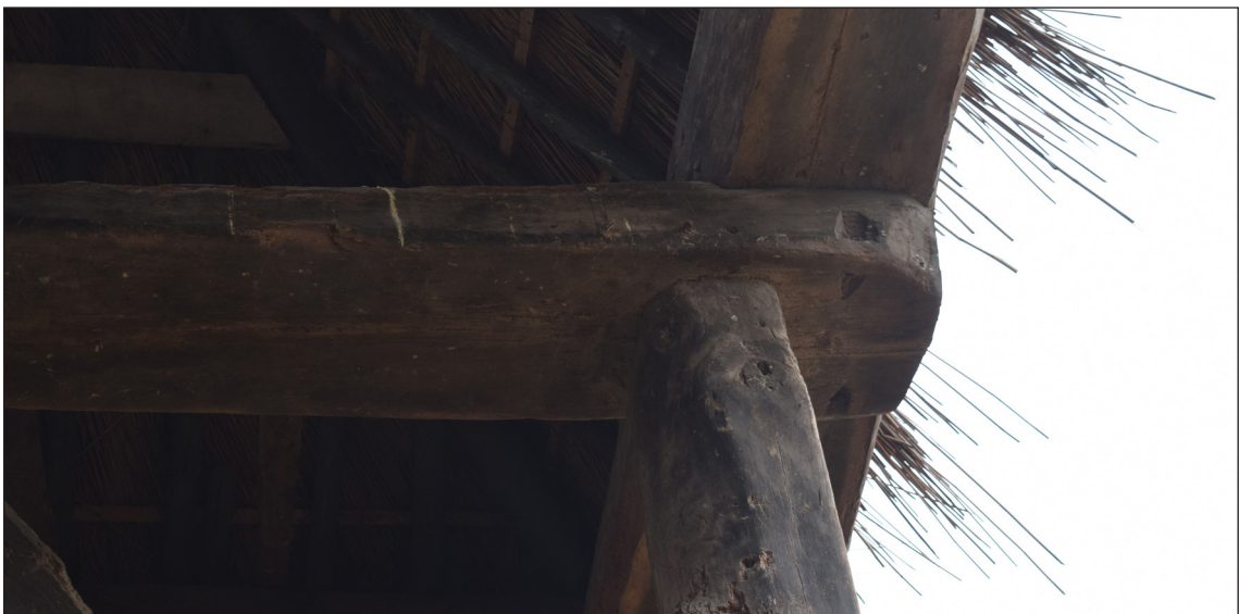
Afbeelding 71. De westelijke dekbalk met in de kop (rechts) twee vlotgaten.
