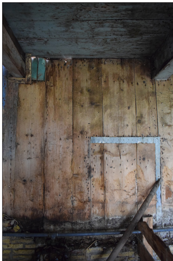
Afbeelding 26. Oostwand van de nette kamer, met een deur naar de dars. De wanden zijn onbeschilderd, maar de rijen spijkertjes wijzen op wandbespanning met behang.
