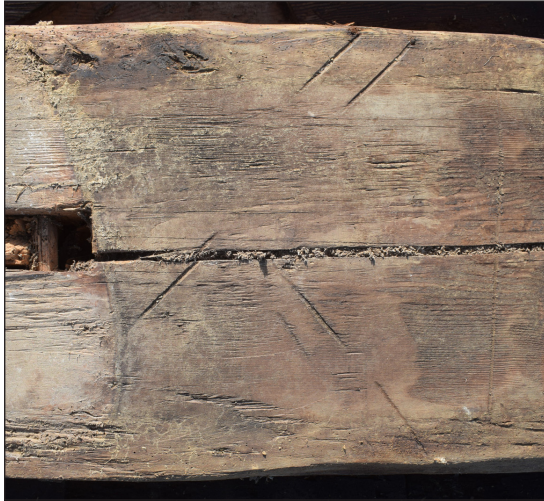
Afbeelding 64. Merk op de oostelijke dekbalk.
