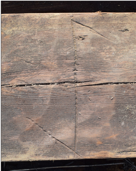
Afbeelding 66. Merk op de oostelijke dekbalk.
