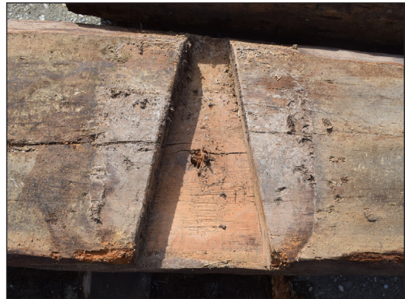
Afbeelding 49. Houtverbinding met loef en voorloef.
