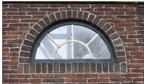
Afbeelding 16. Gietijzeren stalraam in de zuidgevel.
