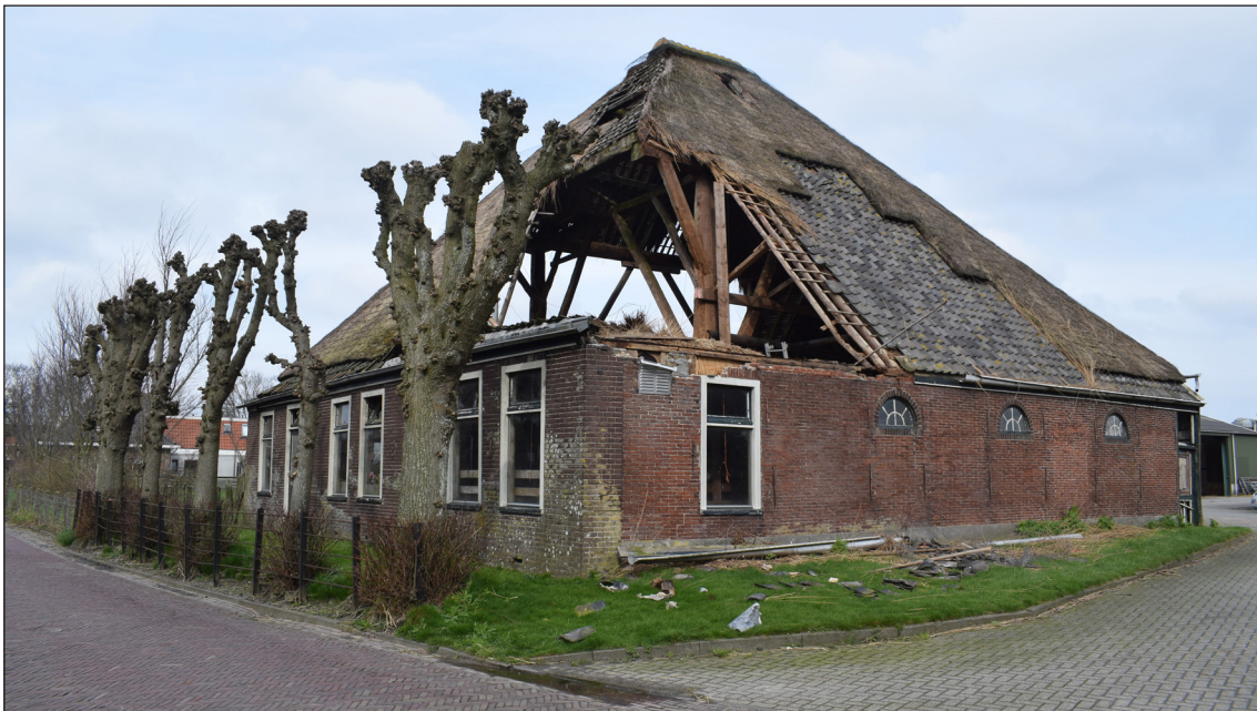
Afbeelding 9. Voorgevel en zuidelijke zijgevel.
