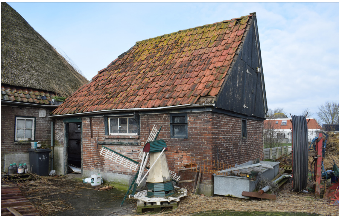
Afbeelding 19. Zuid- en oostgevel van de schuur.
