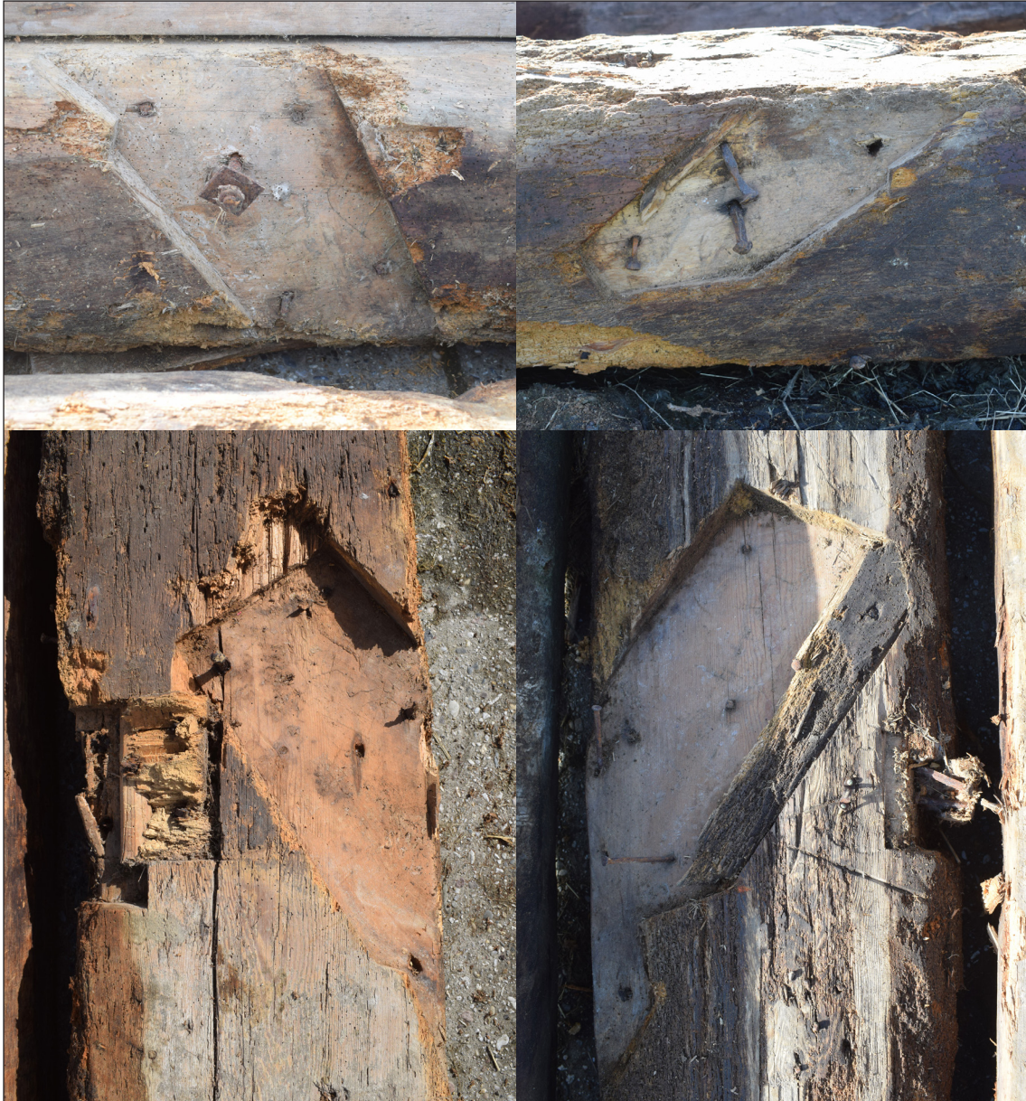
Afbeelding 55. Inkepingen van lipverbindingen met hak.
