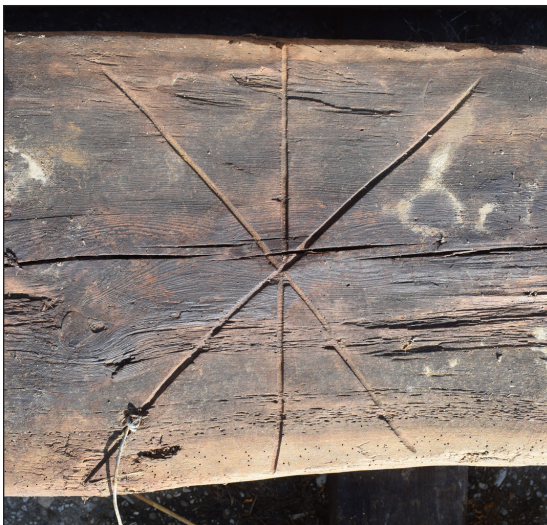
Afbeelding 62. Merk op de overstekbalk.
