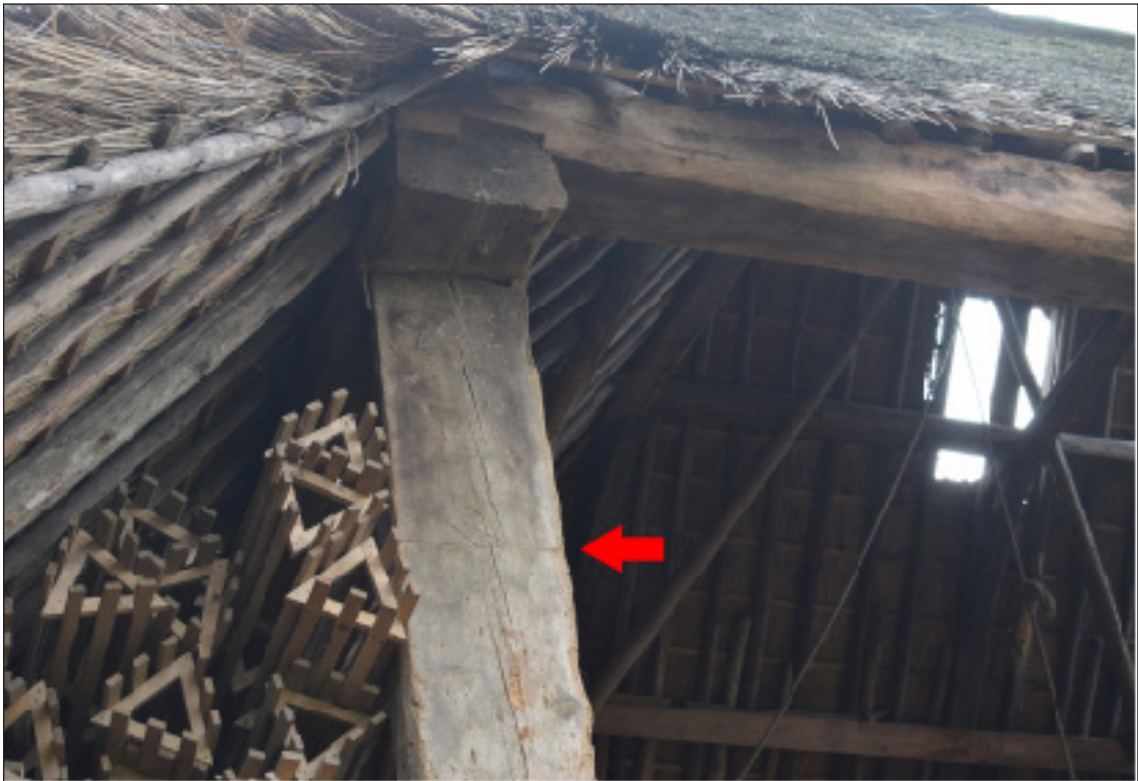
Afbeelding 61. Noordoostelijke stijl met hetzelfde merk (bij de pijl) als afbeelding 60.
