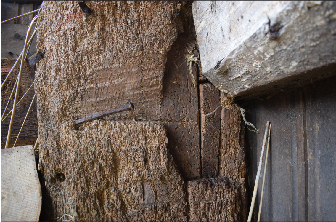
Afbeelding 52. Afgezaagde pen van de originele draagbalk aan de noordzijde, in de noordoostelijke stijl. Erboven een moderne draagbalk.
