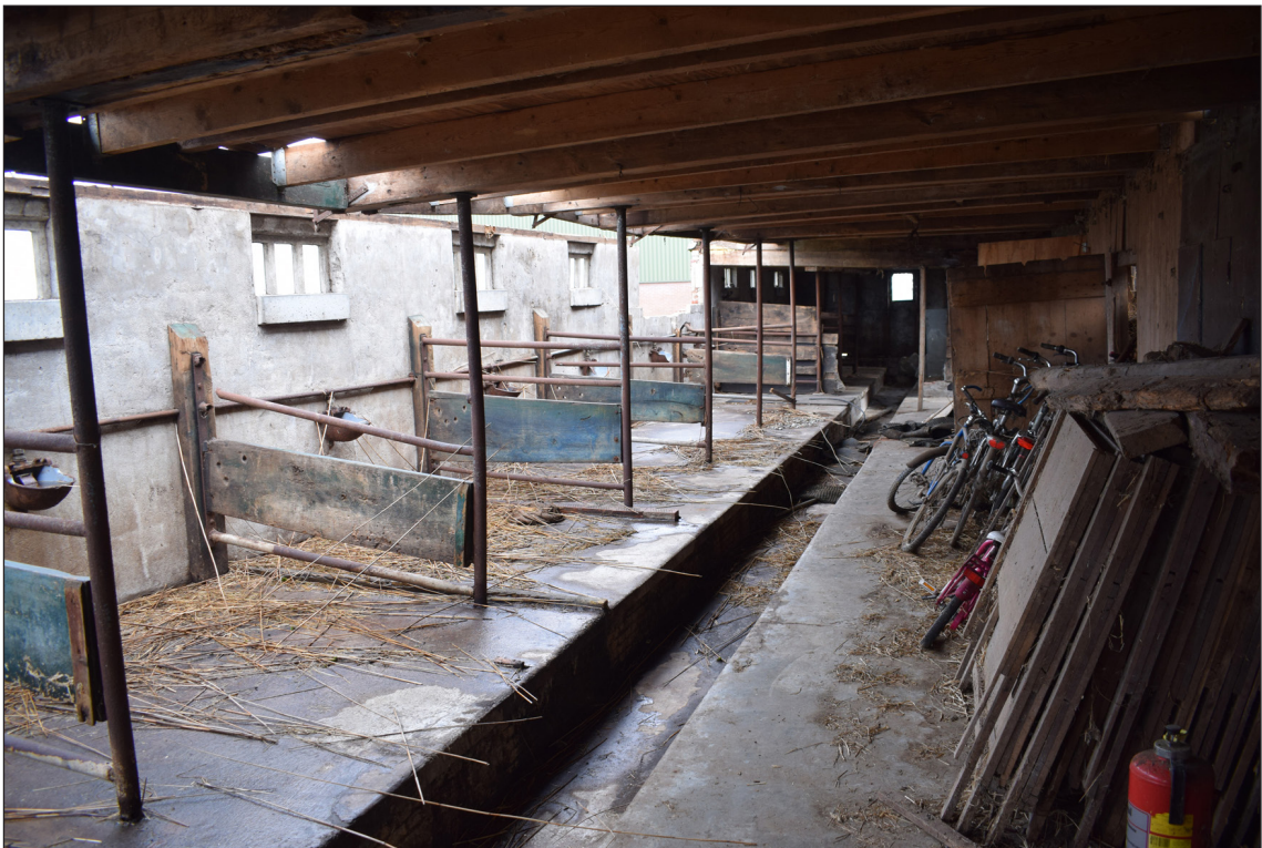
Afbeelding 31. De koeienstal langs de noordelijke zijgevel, gezien richting het oosten.
