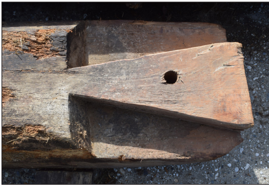
Afbeelding 50. Voorloef op de bovenzijde van de westelijke dekbalk.
