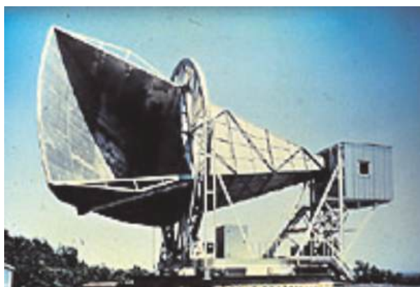
Figura 6.2. Rádio-telescópio com o qual Arnold Penzias e Robert W. Wilson detectaram pela primeira vez, em 1964, a radiação cósmica de fundo.
