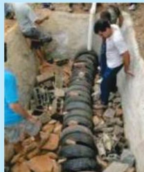
6. Preencha o tanque distribuindo em camadas sucessivas assim, 1ª camada de pedras grandes ou entulho de construção ou de telhas, 2ª camada de brita ou cascalho, 3ª camada de areia e finalmente, na última camada terra.
