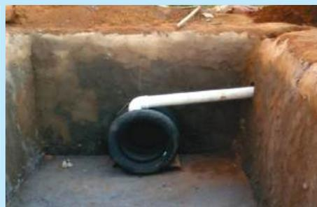
**IMPORTANTE:** É bom que o cano de entrada no primeiro pneu sirva também de tubo de inspeção para verificar o funcionamento da fossa, assim, ele deve ter continuidade para cima do tanque e ter um Cap no topo (ver detalhe nas figuras seguintes).
