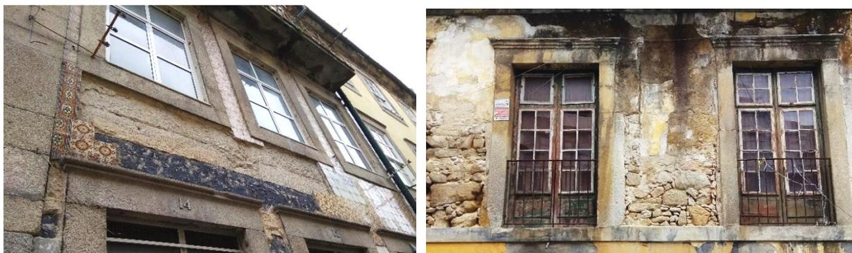
Figura 4.4 –Exemplos de paredes exteriores de alvenaria de pedra na cidade do Porto.
