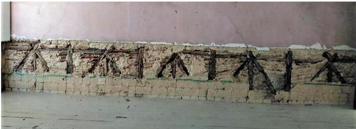
Figura 4.11 – Exemplo de uma parede de frontal.
