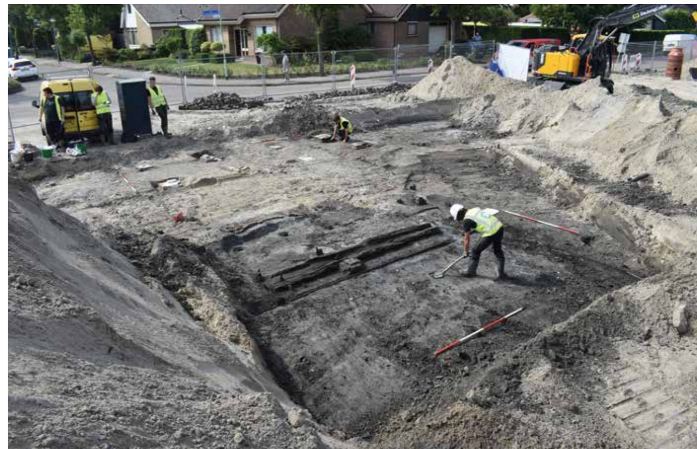
↑ De houten kadebeschoeiing van het balkengat, gemaakt van palen en planken van naaldhout.
