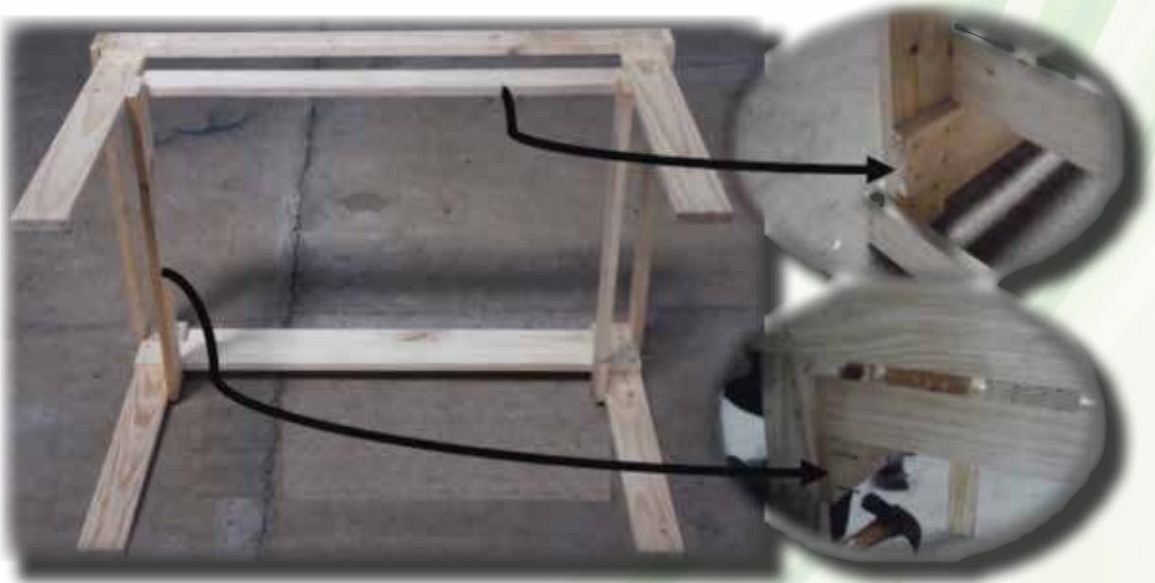
Foto 5. Reforzamiento de las 4 patas que sostienen la cama de cultivo.
