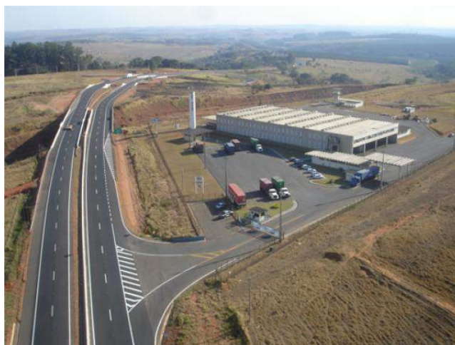
Figura 3: Porto Seco de Bauru – EADI
