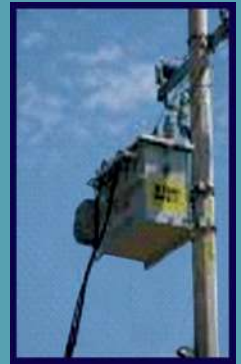
● Arriba, transformador aislado en aceite contenido en una cuba de metal. Abajo, otro de aislación sólida de epoxi; pero su uso se limita a ambientes protegidos de la intemperie.
