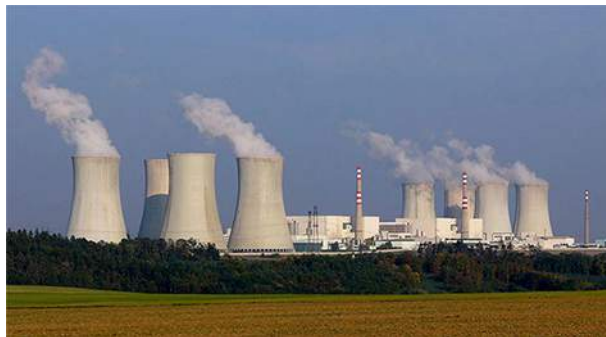
FIGURA 4.5 El calor que se expulsa en una central eléctrica nuclear va a las torres de refrigeración, donde se libera a la atmósfera.
