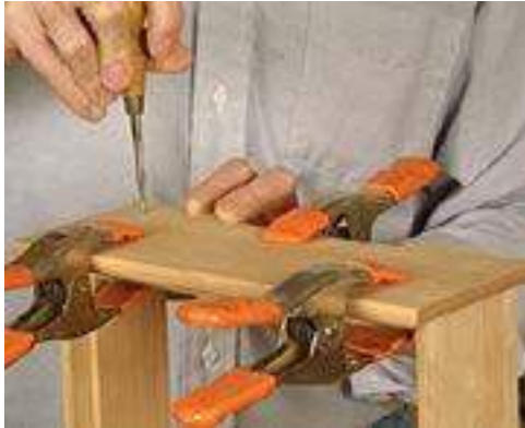
La parte superior se atornilla directamente a los lados, luego se tapa y se recorta al ras.
