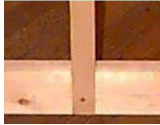
higo. 3: tirante inferior con rebaje de soporte central cincelado
