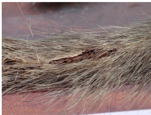
Figura 54 | Oxidação da Armadura que resultou numa fenda. Mariana Costa©, 2022
