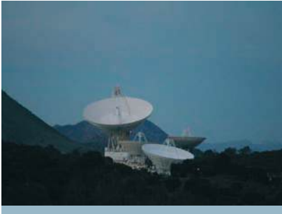
Estación de seguimiento de Satélites de Robledo de Chavela. De las cuatro antenas que aparecen en la imagen, la mayor es la DSS-63, de 70 m de diámetro, y las otras tres de 34 m son la DSS-61 (la antena de PARTNeR), la DSS-65 y la DSS-55. Créditos: Alejandro Sánchez (Universidad Complutense de Madrid).
