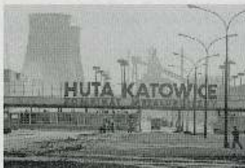
Szaniec się, że w latach 1946–1985 zbudowano ponad 1300 nowych dużych zakładów przemysłowych. Jednym z nich była Huta Katowice w Dąbrowie Górniczej.
