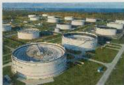
Firma PERN SA zarządza siecią rurociągów (1843 km to rurociąg naftowy i 636 km rurociąg paliwowy) oraz 23 bazami magazynowymi, w tym nowo zrealizowanym Terminalem Naftowym w Gdańsku.
