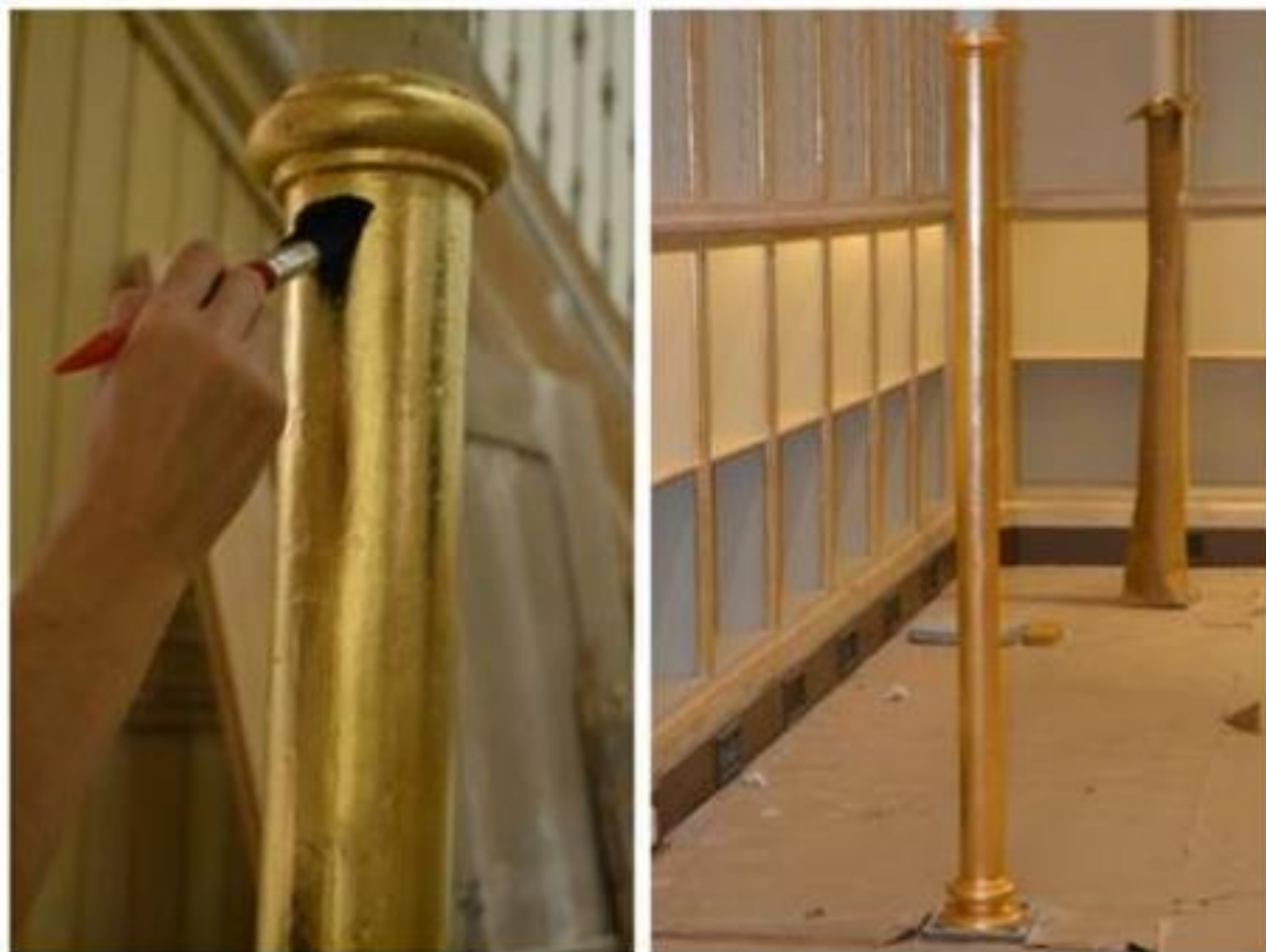
Fig. 7 – Aplicação da camada de proteção sobre os douramentos. Fonte: de elaboração própria.
