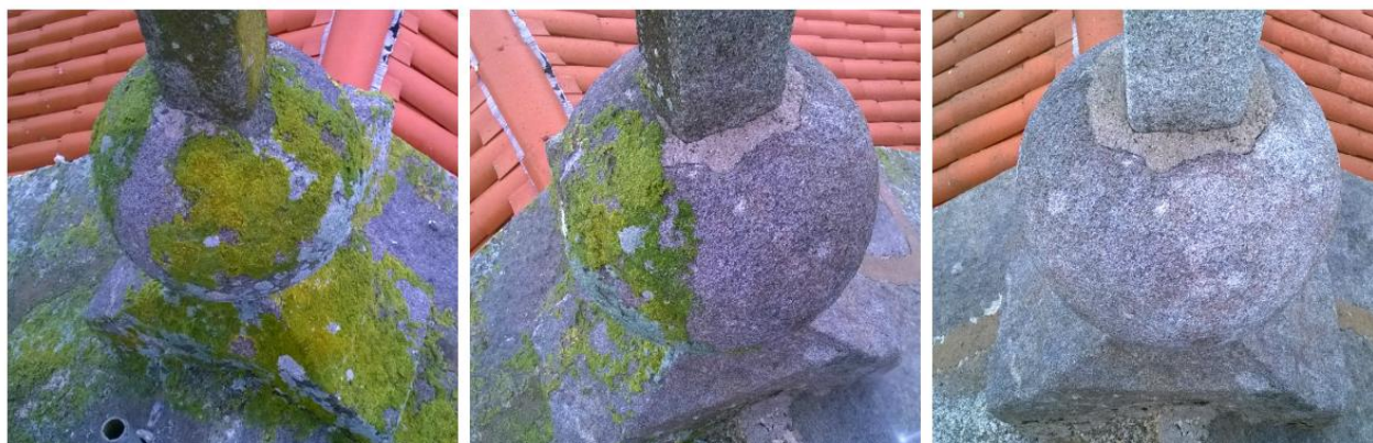
Fig. 3 – Limpeza dos elementos pétreos da Fachada principal: Remate da Fachada antes, durante e após a limpeza). Fonte: de elaboração própria.
