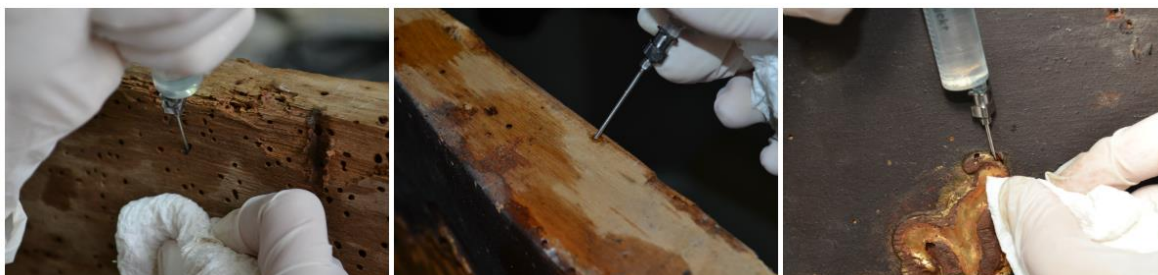
Fig. 54 – Consolidação por aplicação de consolidante através de injeção nos orifícios de saídas dos insetos xilófagos. Fonte: de elaboração própria.
