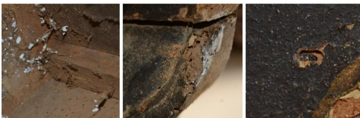
Fig. 14 – Vestígios de atividade biológica: Teias de aranha; serrim fresco e inseto xilófago presente no interior da estrutura lenhosa (respetivamente, segundo o esquema de leitura ocidental). Fonte: de elaboração própria.
