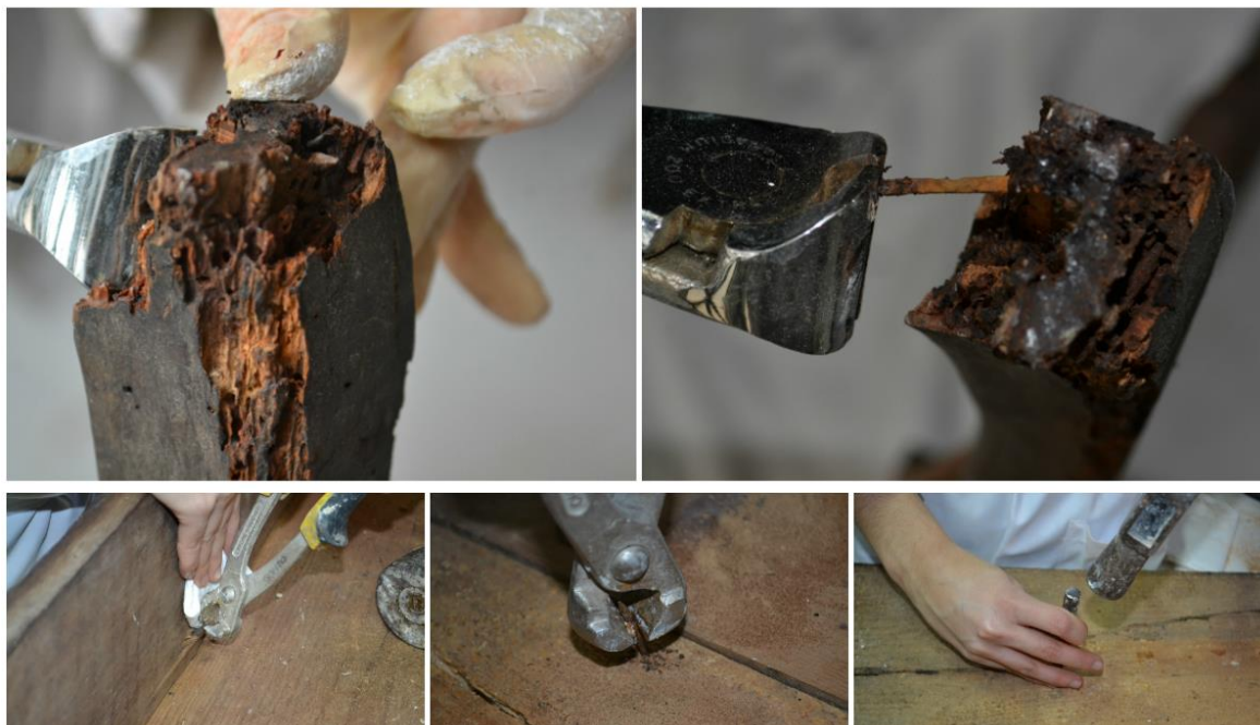
Fig. 52 – Remoção de elementos metálicos oxidados e corroídos. Fonte: de elaboração própria.
