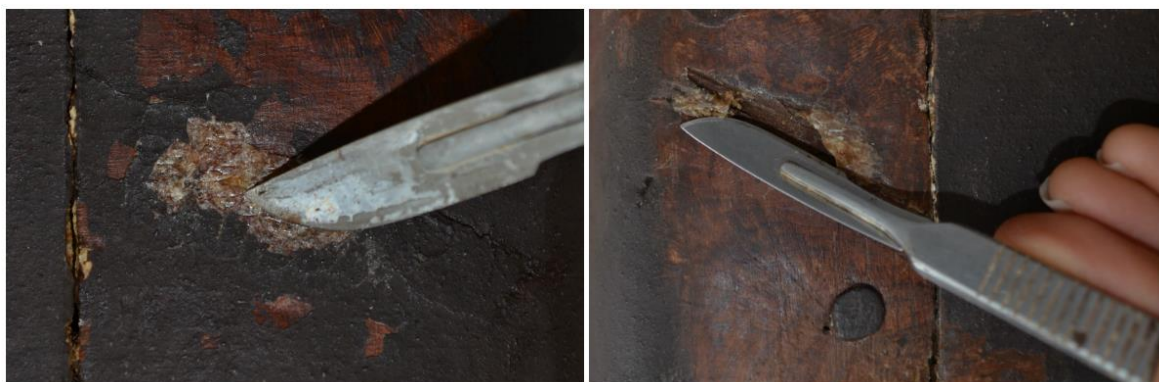
Fig. 62 – Remoção de um preenchimento anterior com recurso ao uso de uma lâmina de bisturi. Fonte: de elaboração própria.
