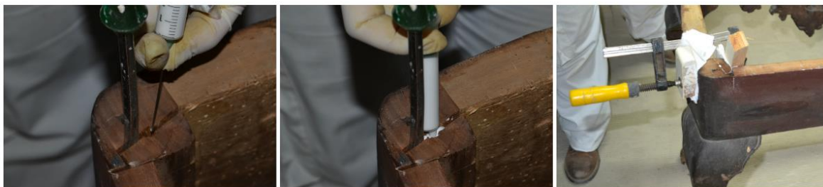
Fig. 65 – Colagem de fendas com respetivo aperto para garantir eficácia do processo. Fonte: de elaboração própria.
