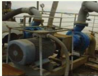
Fig 1. Motores eléctricos conectados a un compresor de refrigeración y a bombas centrífugas
