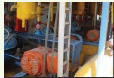
Fig 1. Motores eléctricos conectados a un compresor de refrigeración y a bombas centrífugas
