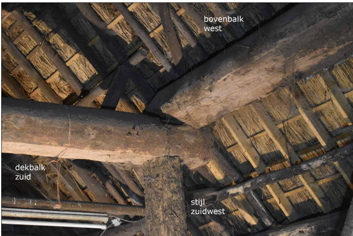
Afbeelding 15. Bovenkant van de zuidwestelijke stijl met de dekbalk en bovenbalk daarop.
