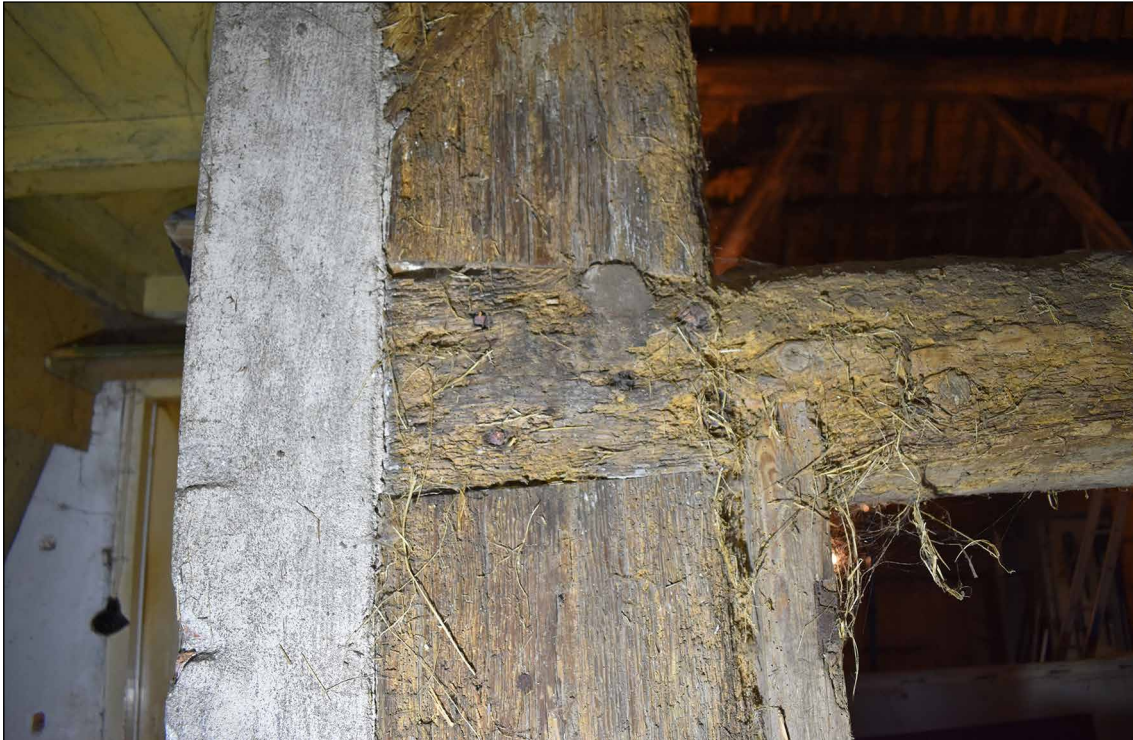
Afbeelding 20. Bevestiging van de oostelijke draagbalk met de zuidoostelijke stijl.
