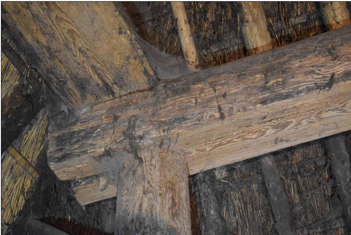
Afbeelding 10. De noordwestelijke stijl met de noordelijke dekbalk en bovenbalk aan de westzijde. Op de ronde zijden is de gevlamde structuur van het naaldhout duidelijk zichtbaar.
