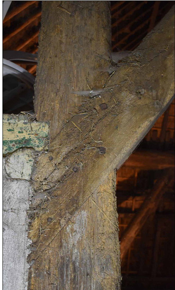
Afbeelding 18. Bevestiging van een zwing aan een stijl door middel van een lipverbinding met hak.
