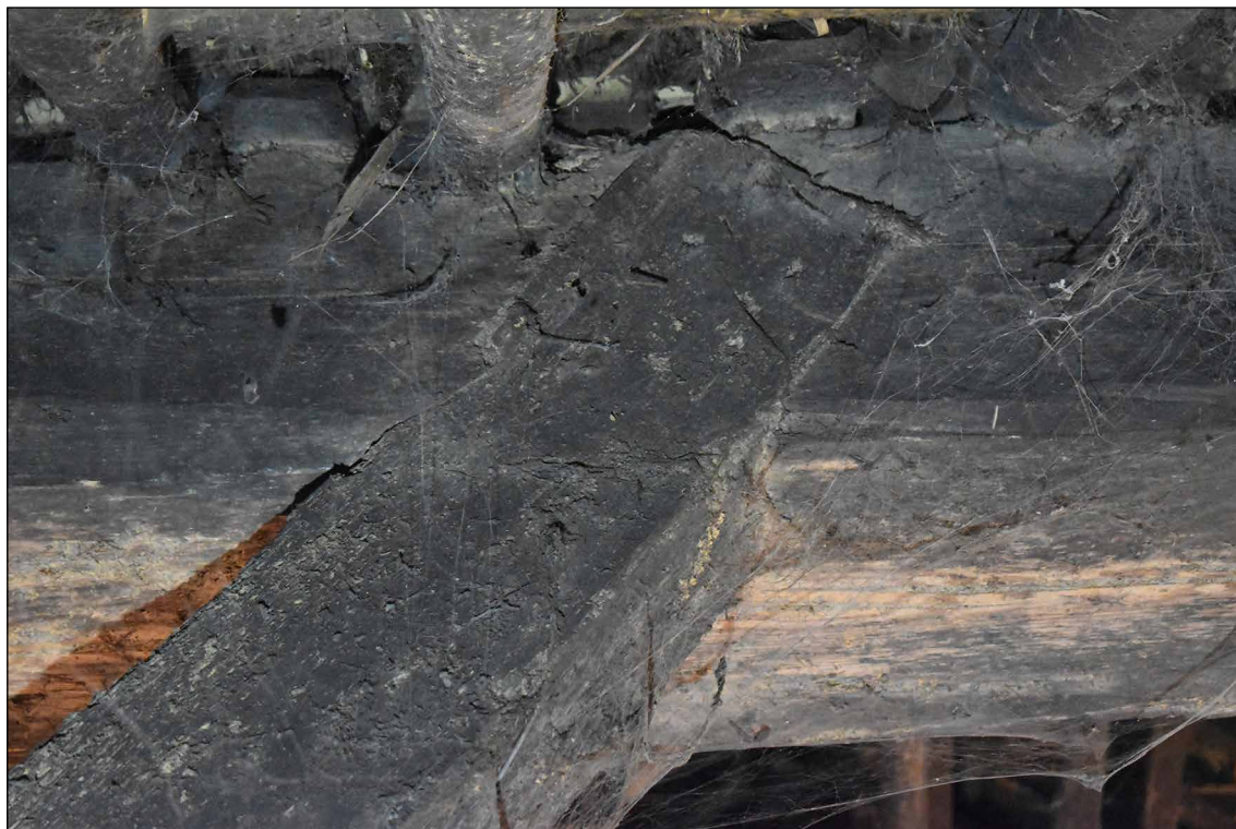
Afbeelding 17. Bevestiging van een zwing aan een dekbalk door middel van een lipverbinding met hak.
