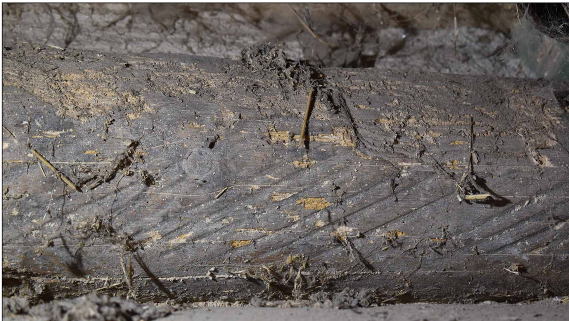
Afbeelding 19. Groeven in de draagbalk aan de zuidzijde.
