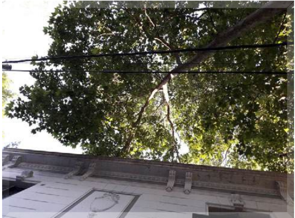
Foto 6.2. Ramas producen interferencias sobre una vivienda.
