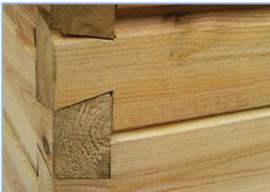
Fig. 29 Ensamble de en cola de milano.
