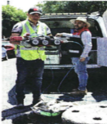
Personal aún realiza labores en el lugar.
