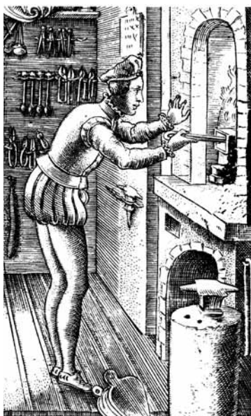
Figura 9 – Orfebre recociendo un objeto de hierro en el horno
