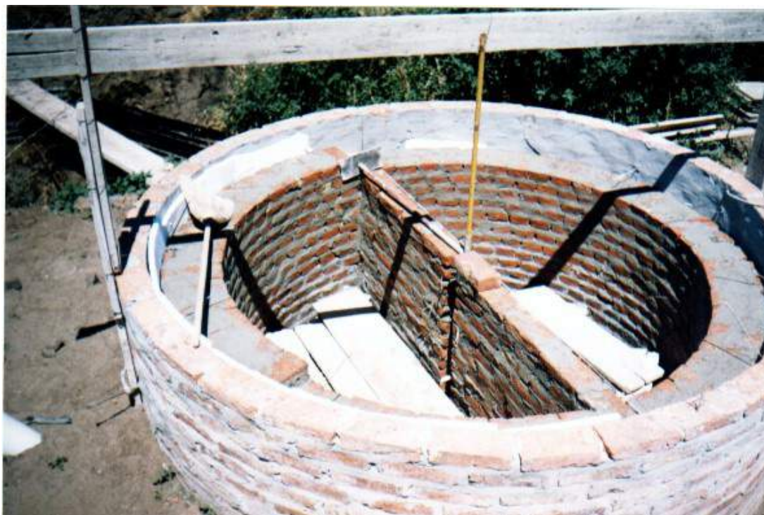
Figura 4. Vista de la construcción del digester tipo Hindú de la Escuela Inchausti, realizado por el Proyecto de Extensión seleccionado en el Concurso de Proyectos por el Gobierno de la Provincia de Buenos Aires y el Ministerio de Cultura y Educación de la Nación – UNLu.
