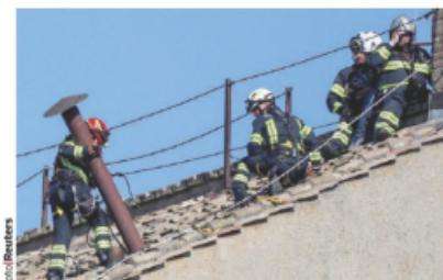
BOMBEROS colocan ayer la chimenea en el tejado de la Capilla Sixtina.
