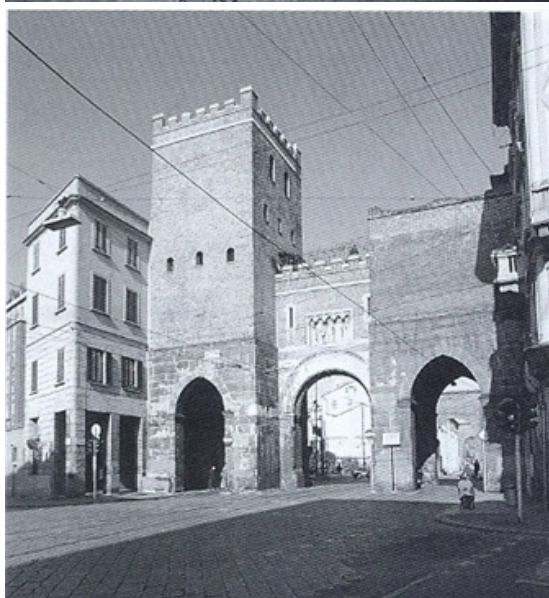
Fig. 4/5 – Porta Ticinese , Milão. Estado antes do restauro e após a intervenção de Boito (1861-65). Fonte: MARCONI, 2003, pp. 130-131.
