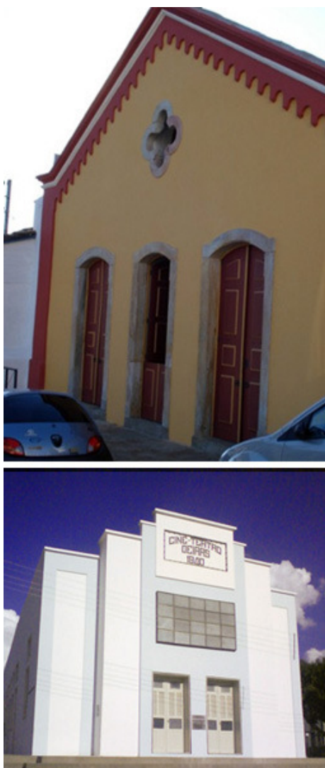
Fig. 42/43 – Ouro Preto, antiga Casa de Ópera , atual Teatro Municipal. Oeiras, Cine-teatro . Destaque para a total repintura das fachadas. Fonte: www.monumenta.gov.br .
