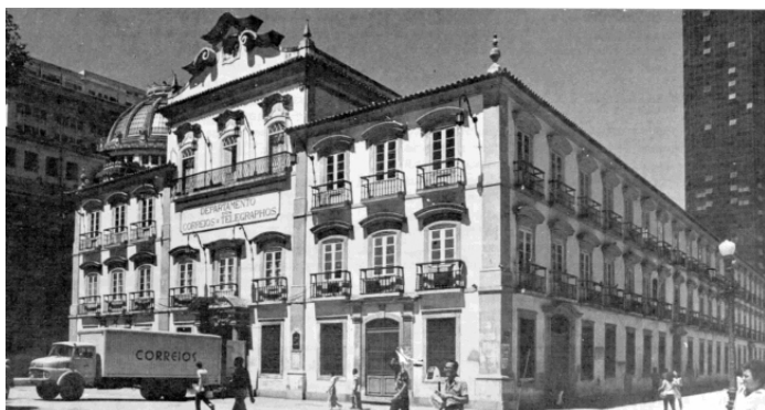
Fig. 24 – Paço Imperial, Rio de Janeiro, década de 1980, antes das obras de restauro. Fonte: Revista do Patrimônio , n. 20, pp. 141.
