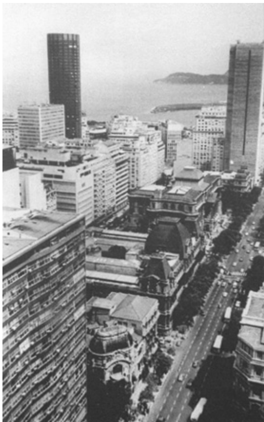
Fig. 20 – Conjunto arquitetônico da Avenida Rio Branco, Rio de Janeiro. Fonte: COSTA, 1999, pp. 299.
