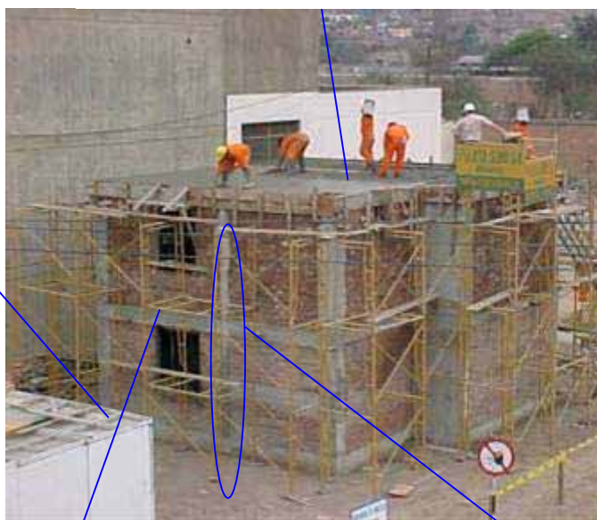
Detalle de la columna de confinamiento en toda su longitud
