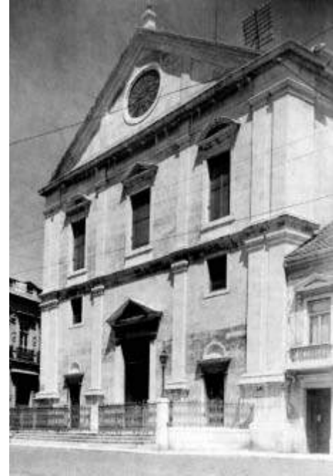
1 – Fachada da igreja jesuítica de São Roque, Lisboa.
