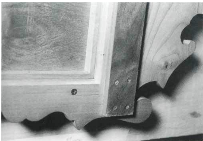
Este primer plano muestra cómo se ensamblan las volutas, la tira de tachuelas y la abrazadera.
