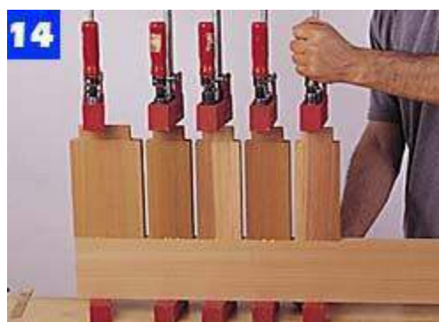
La primera etapa en el montaje de una mesa de trabajo es pegar y sujetar listones a un montante. Use una abrazadera en el centro de cada tablilla.
