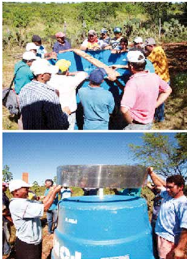
Figura 10 – Capacitação na construção do Biodigestor Sertanejo
